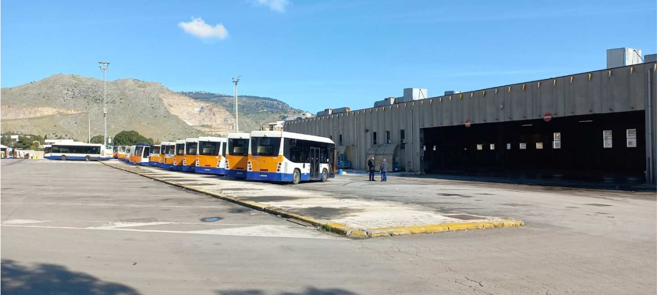
Marciapiede centrale dedicato all'installazione di 34 colonnine di ricarica lenta doppie
