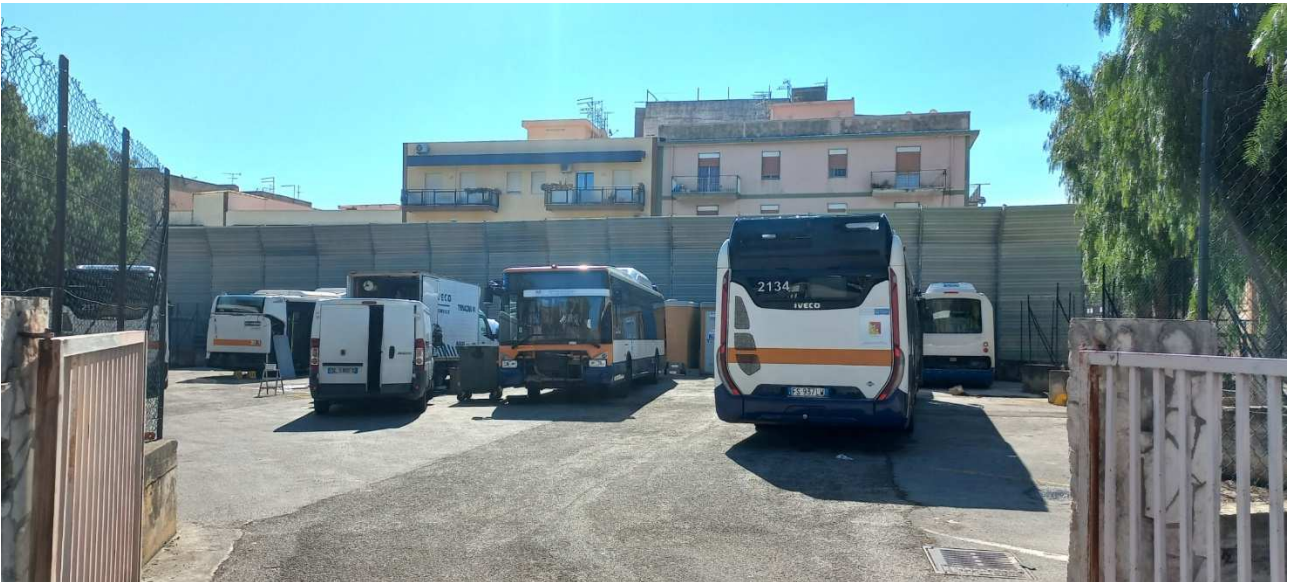
Area dedicata all'installazione della nuova cabina elettrica MT/BT di smistamento
