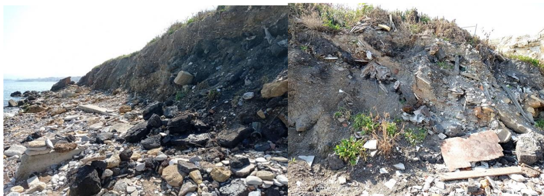
Figura 12 - Foto della linea di costa coinvolta dal fenomeno erosivo
