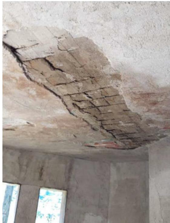
Foto 5. Piano Rialzato - Degrado Strutturale
