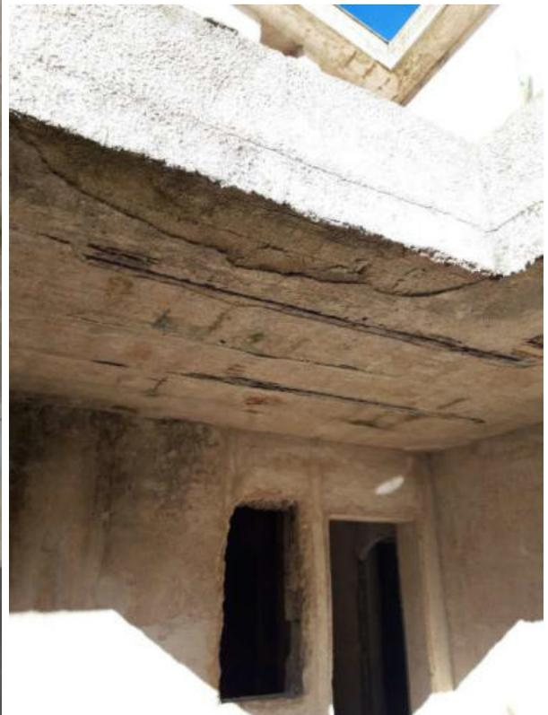
Foto 7. Piano Primo – Degrado del Solaio
