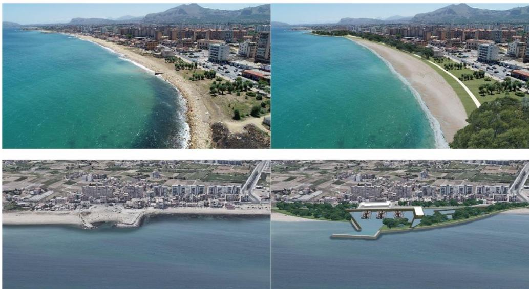
Verso il largo detto elemento è costituito da un muro frangionde, realizzato in cassoni cellulari galleggianti in c.a. A protezione del "piede" del muro si prevede di collocare una scogliera naturale con massi di idonea dimensione. La sezione superiore del muro è articolata in modo da formare un camminamento pedonale che si connette agli altri camminamenti del luogo.
