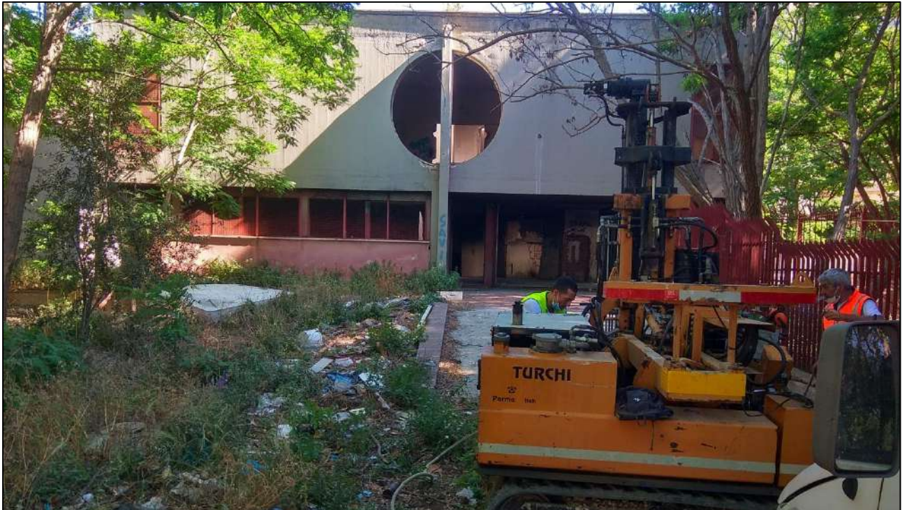
Foto postazione sondaggio S1
