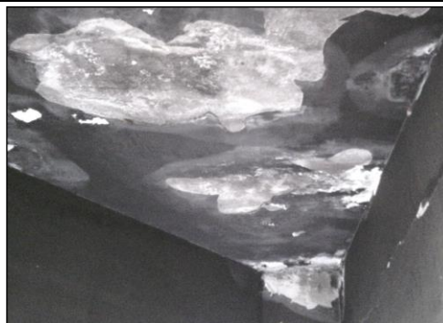
Termografia n.2.1 senso di armatura del solaio zona palco, alla destra del palco.
