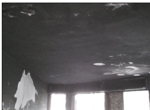
Termografia n. 1.4 senso di armatura del solaio della stanza laterale di piano terra
