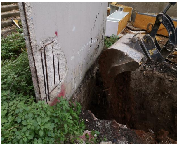
Foto 8 – Saggio alle fondazioni.
