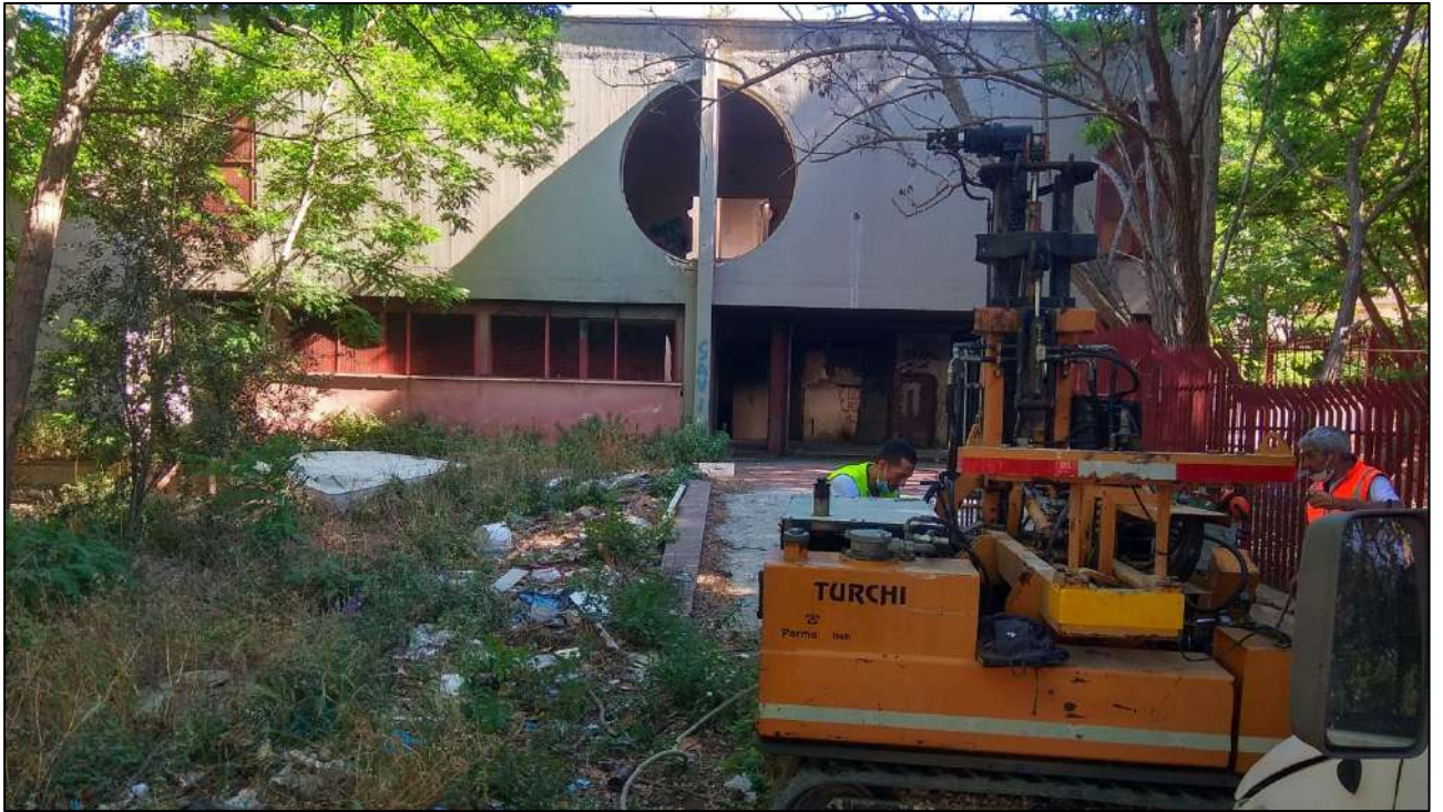
Foto postazione sondaggio S1
