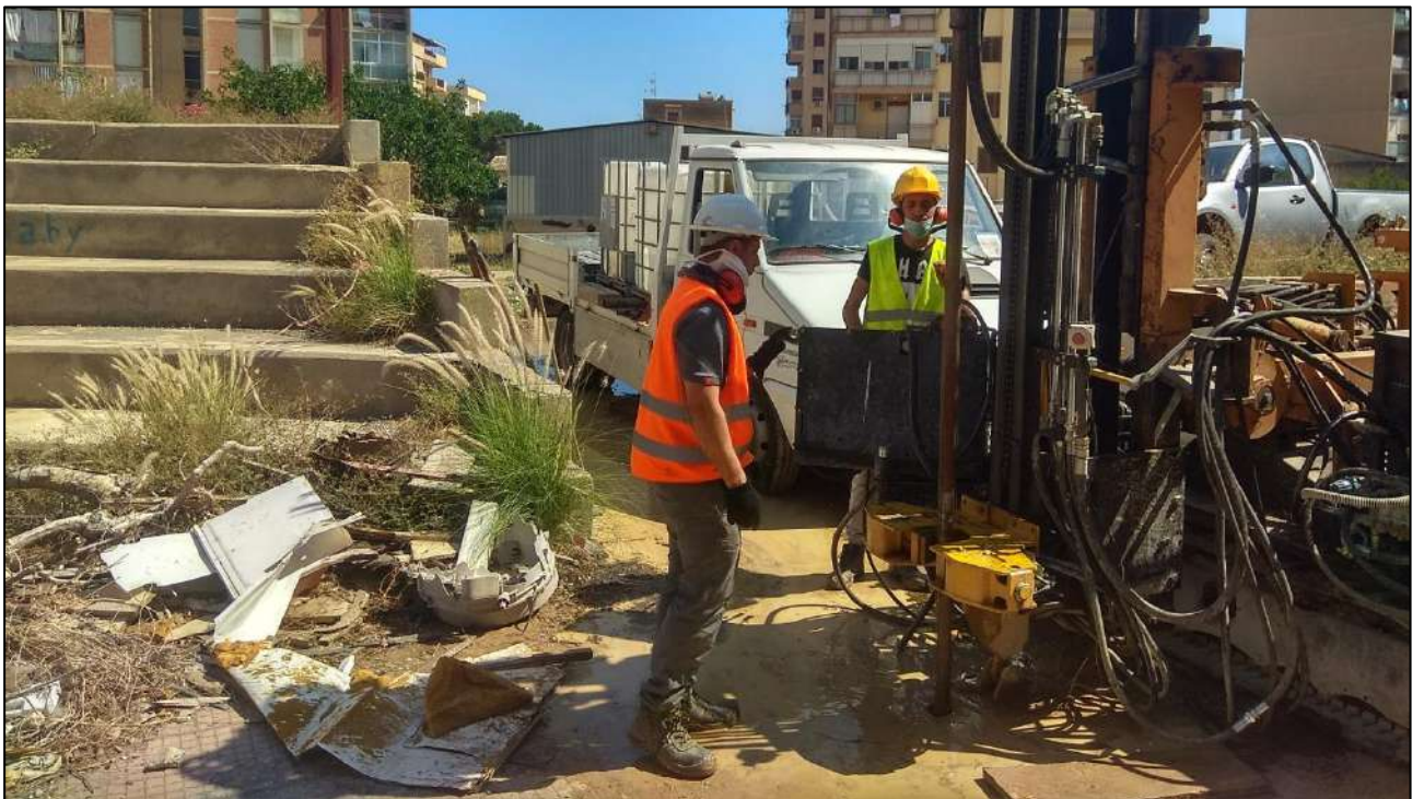
Foto postazione sondaggio S2
