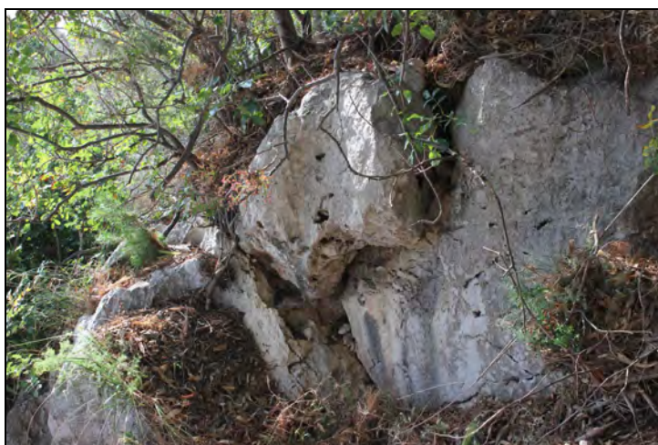
Foto 5 – Settore (B) Alcuni blocchi calcarei presenti sul bordo superiore della scarpata che andrebbero stabilizzati mediante imbracatura con funi in acciaio.
