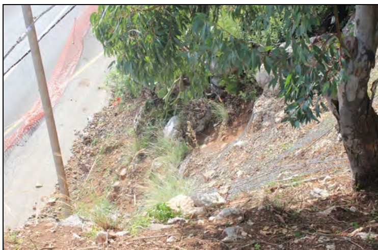
Foto 4 – Settore (B) Trascinamento della coltre detritica sulla sede stradale anche in presenza di reti di protezione esistenti.
