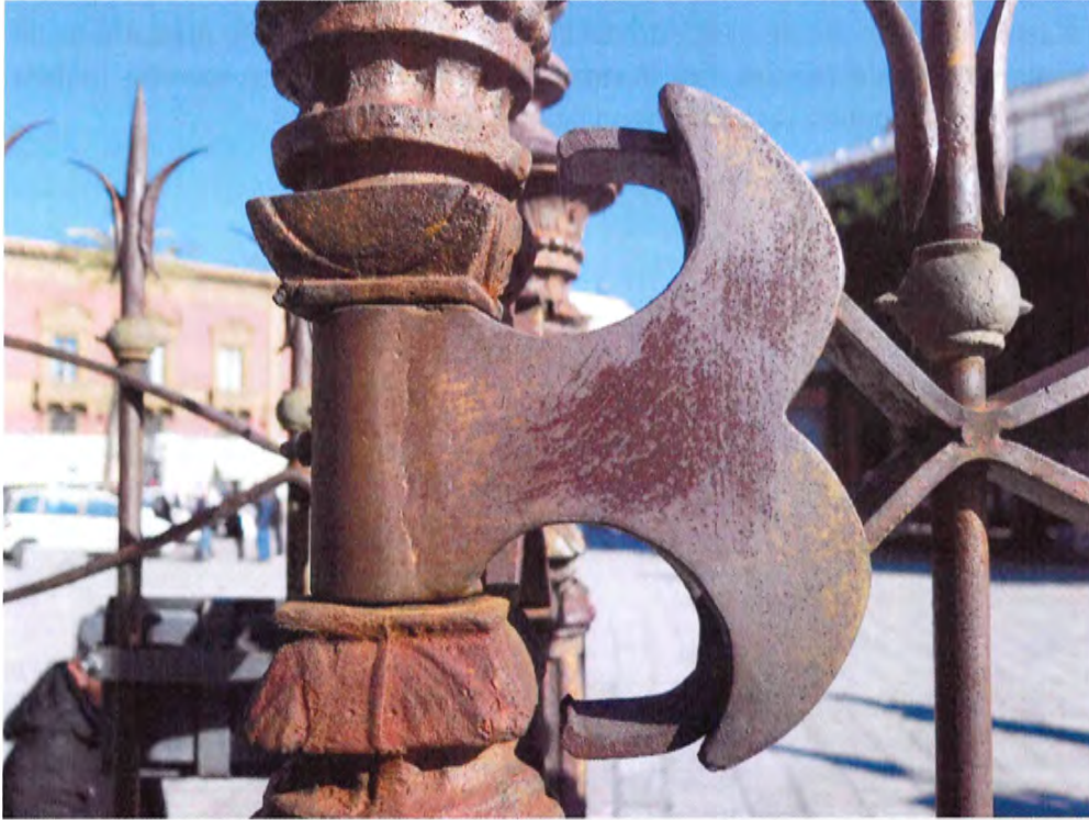
Figura 10 - Cancello 12. Degenerazione dello strato protettivo acrilico nella cerniera superiore.
