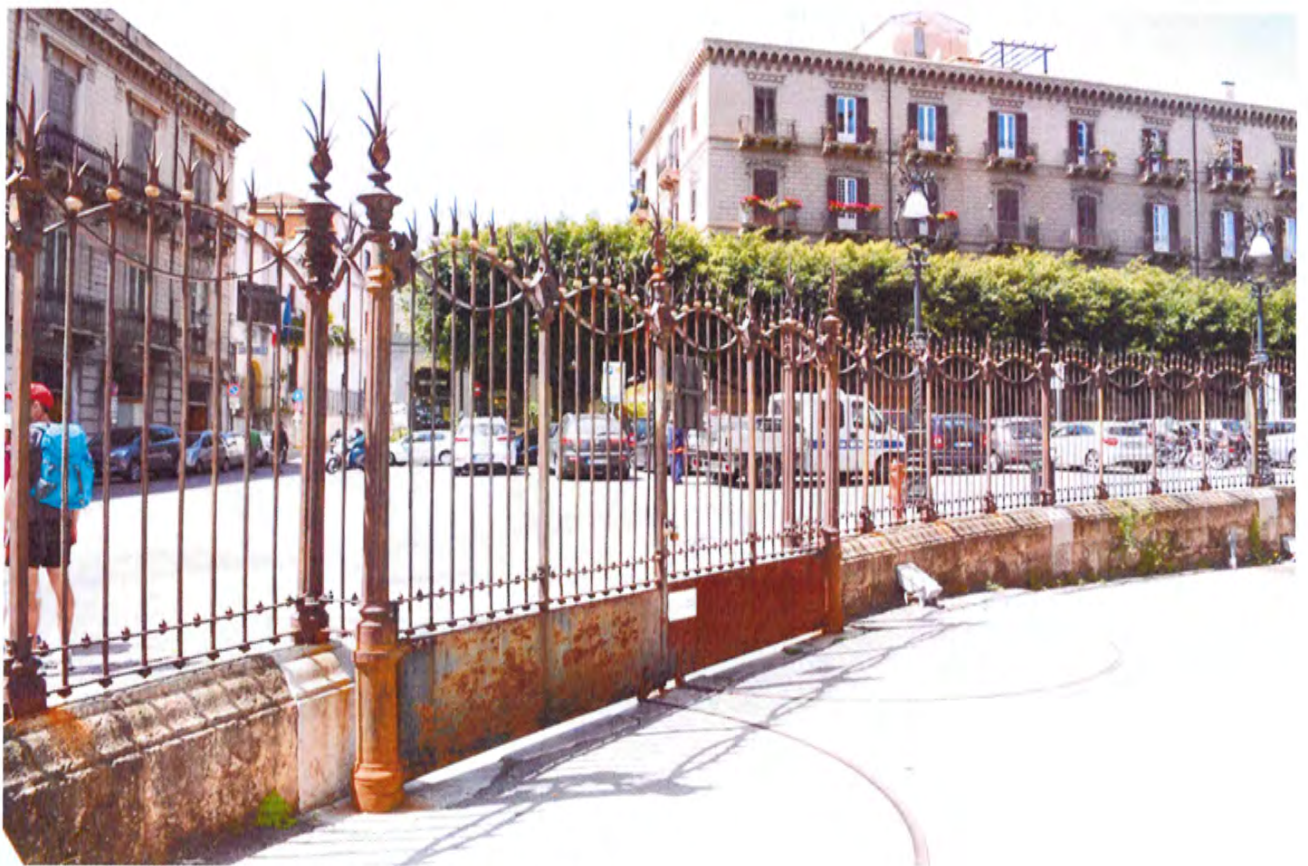
M – CANCELLO 7 – Visioni della faccia interna verso il parterre.
