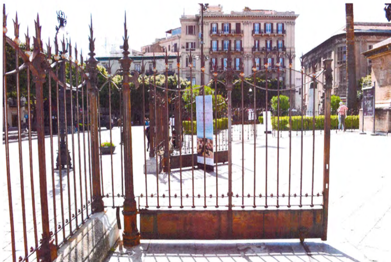
B – CANCELLO 1 - Visione delle facce esterne verso il parterre.
