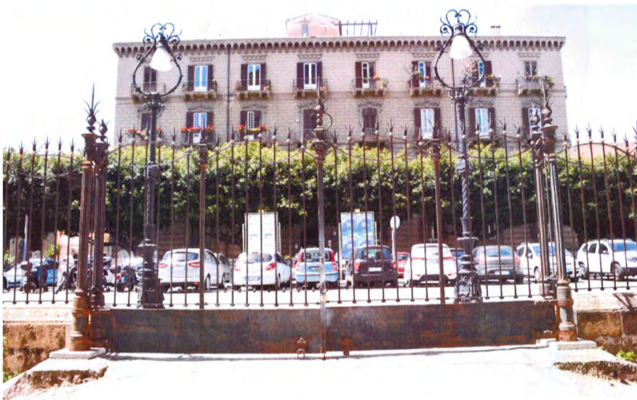
N – CANCELLO 8 – Visioni delle due facce del cancello.
