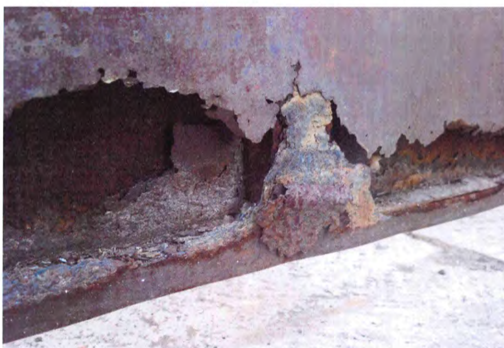
Figura 7 - Cancellata 5. Particolare dell'anta sinistra vista dalla piazza
