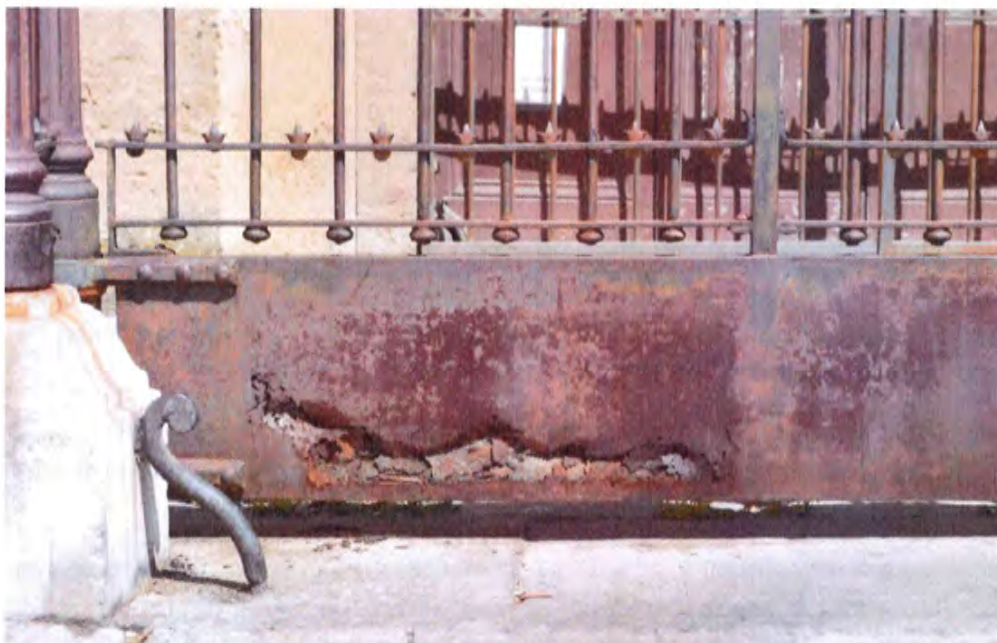
Figura 5 - Cancello 5. Particolare dell'anta sinistra vista dalla piazza.
