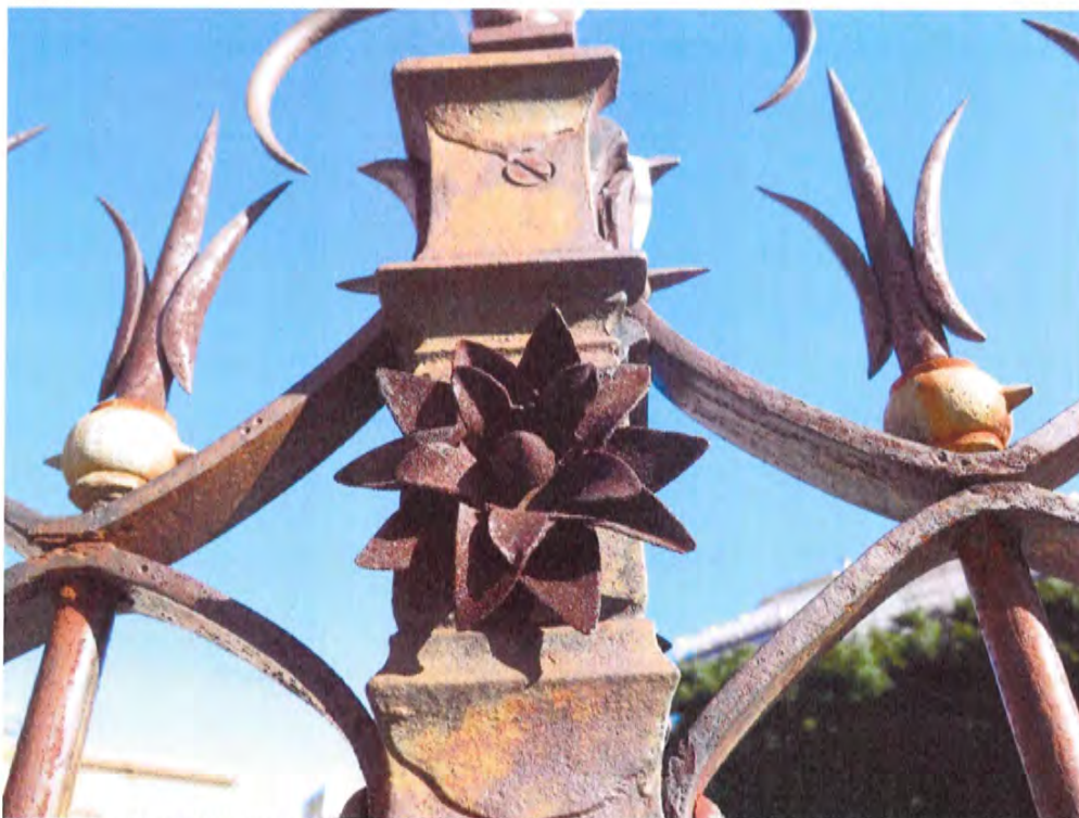
Figura 11 – Degenerazione dello strato protettivo con formazione di patine ossidate.
