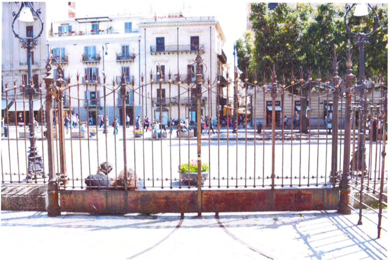
C - CANCELLO 2 - Visioni dell'intero cancello nelle due facce esterna ed interna.
