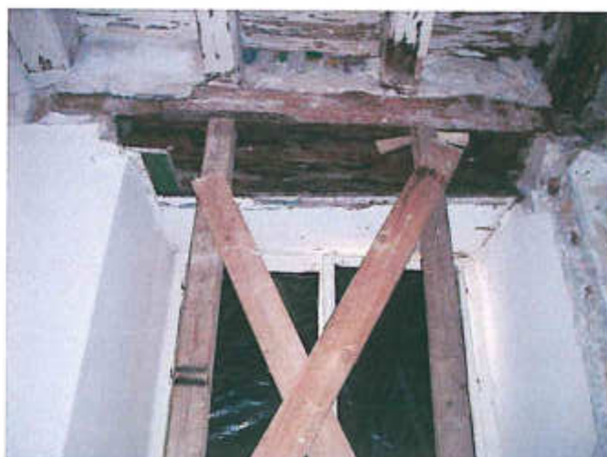
Vista degli architravi del secondo piano
