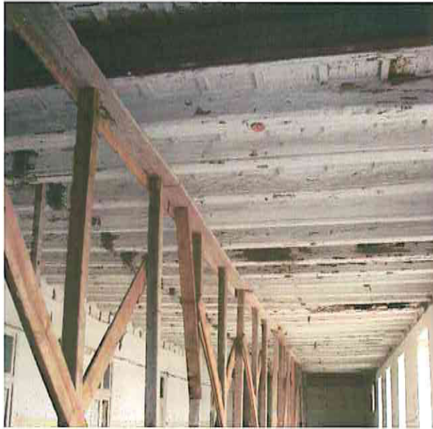
Vista intradossale del solaio del secondo piano Si noti la posizione del tramezzo sulla foto precedente, evidenziata dall'assenza di vernice su tutte le travi
