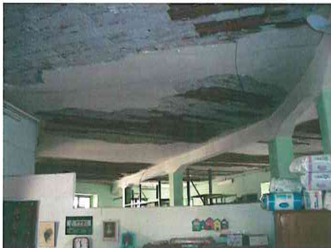
Vista del solaio in latero-cemento del corpo H
