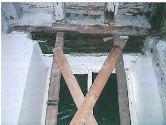
Vista degli architravi del secondo piano
