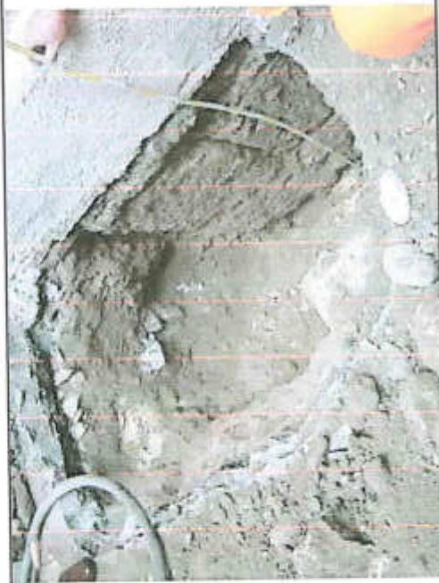
SCAVO D'ISPEZIONE P2 (via Scarparelli)
