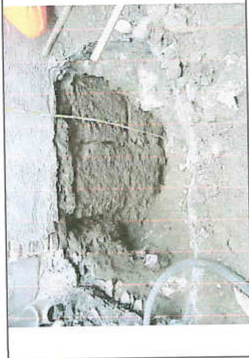
SCAVO D'ISPEZIONE P2 (via Scarparelli)
