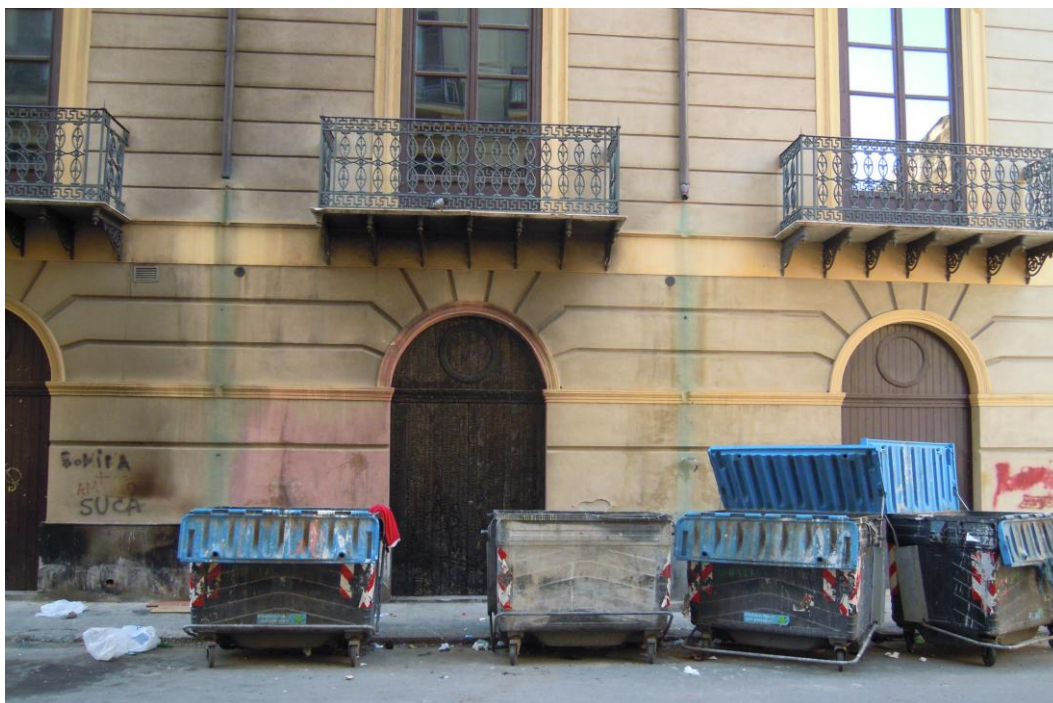
Fig. 2 – Facciata su via Gorizia in prossimità dell'angolo con via Garibaldi (da sinistra, civici 46, 48).
