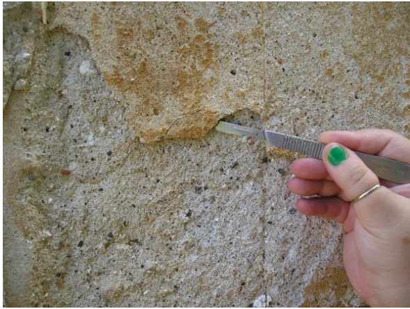
Saggi stratigrafici - intonaco esterno
