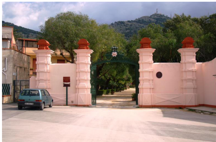
Piloni d'Ingresso a Villa Niscemi dopo ultimo intervento oggetto di segnalazione
