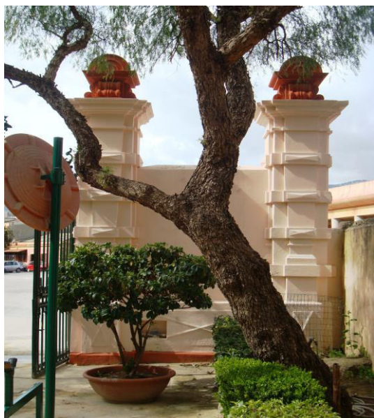
Piloni d'Ingresso - particolare retro prospetto
