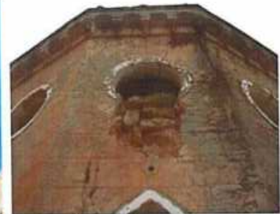
integrazione di muratura
