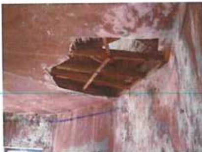
Corpi solaio scala in legno
