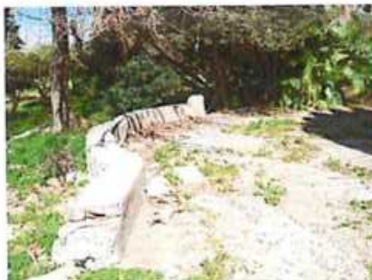
Sistemaz. Area esterna
