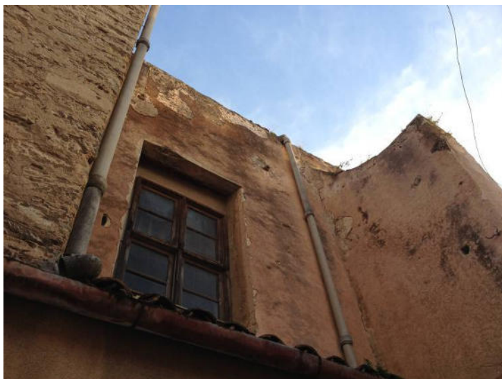
Prospetto laterale nord- ovest. I pluviali in Eternit.
