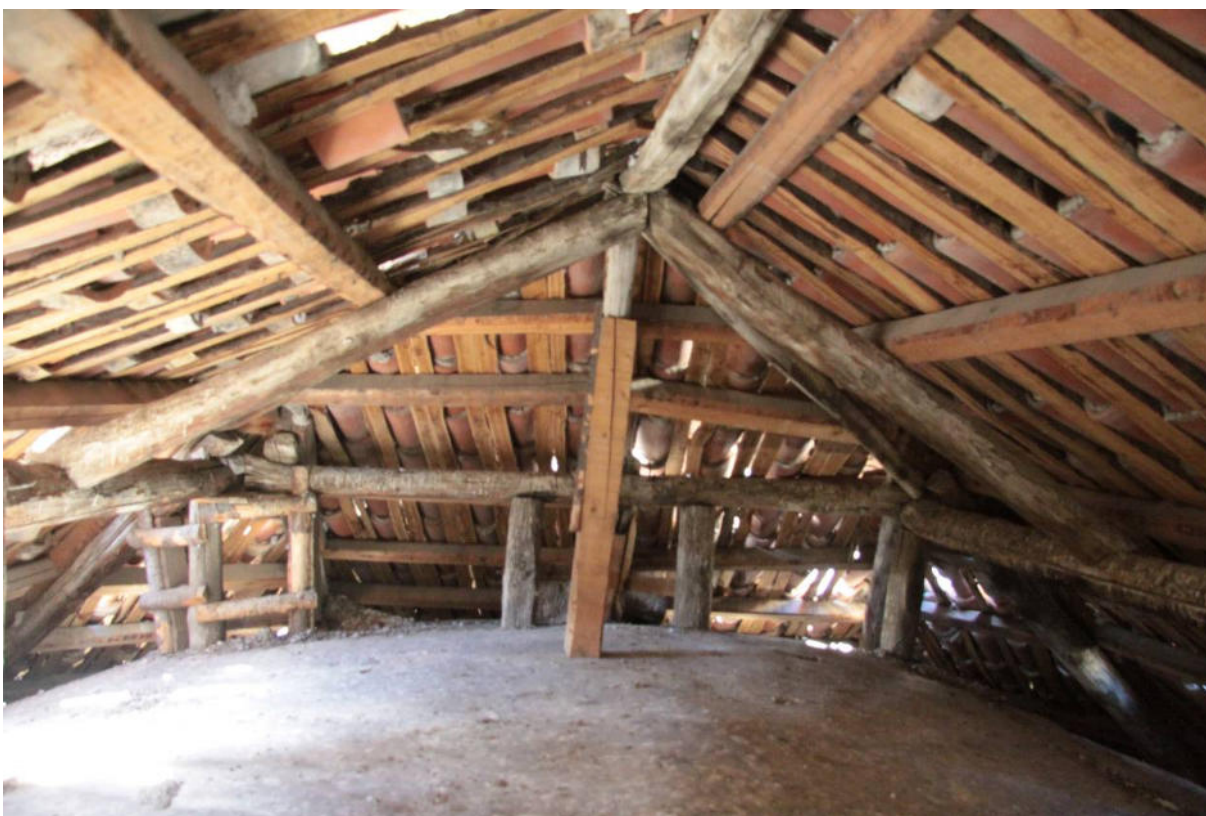
Vista del sistema della copertura della parte absidale. Si possono notare gli elementi lignei posti a sostegno dei puntoni che scaricano sulla calotta absidale.
