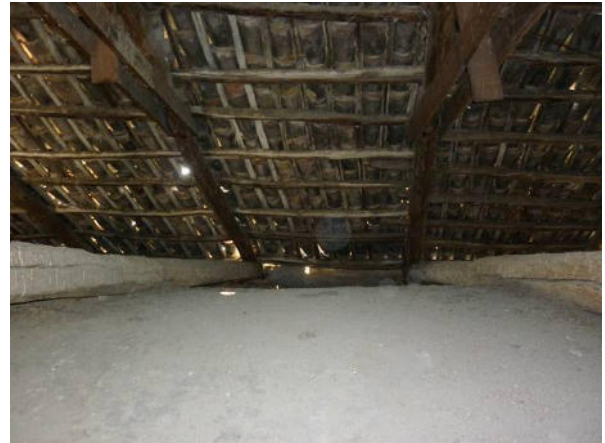
Particolari del sottotetto con il sistema di copertura
