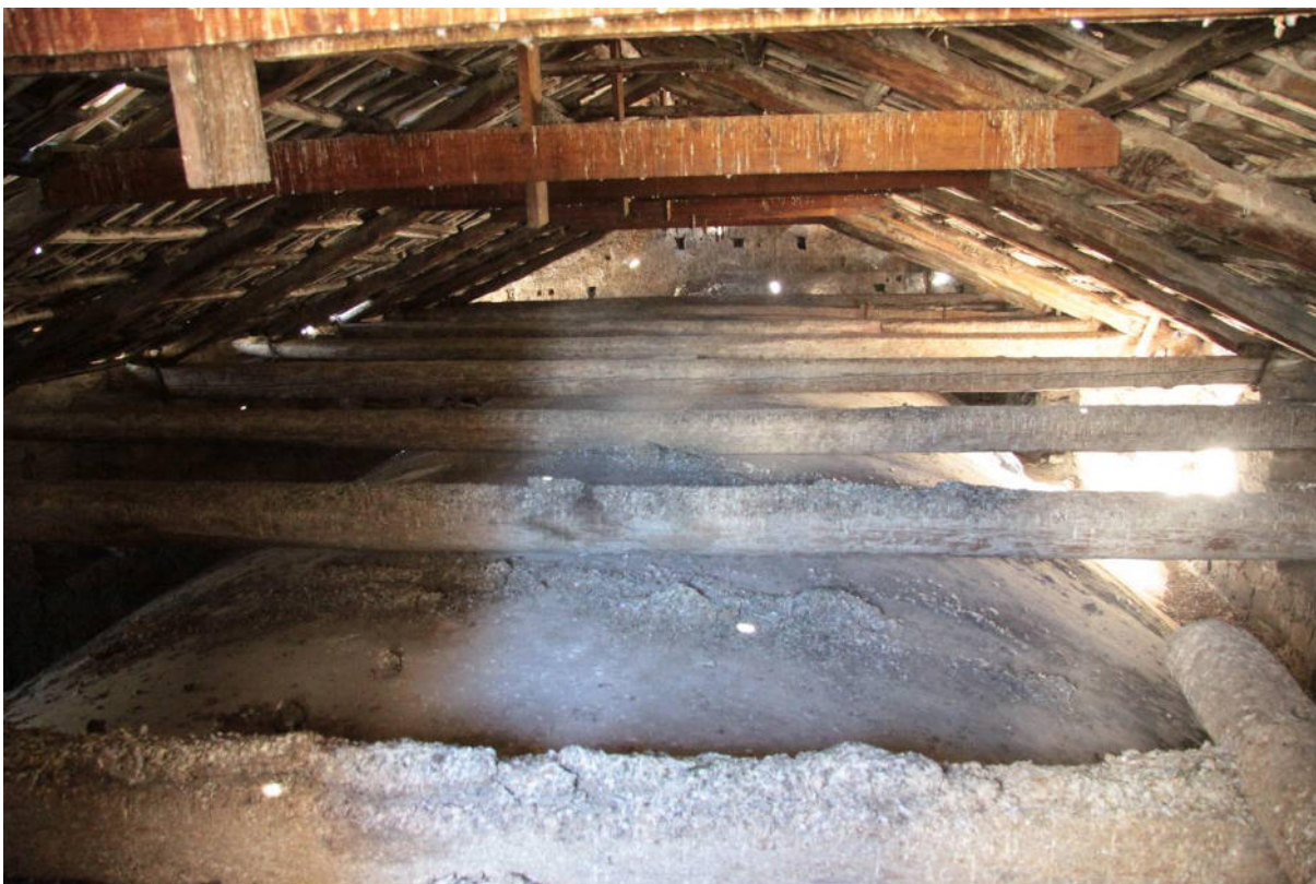
Vista delle capriate del sistema di copertura della navata centrale..
