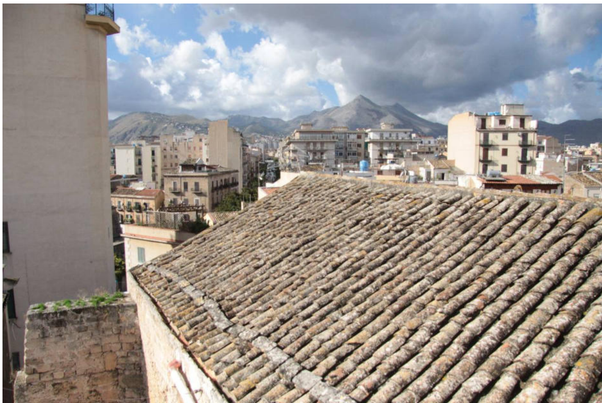
Vista, dal campanile, del tetto della navata centrale.
