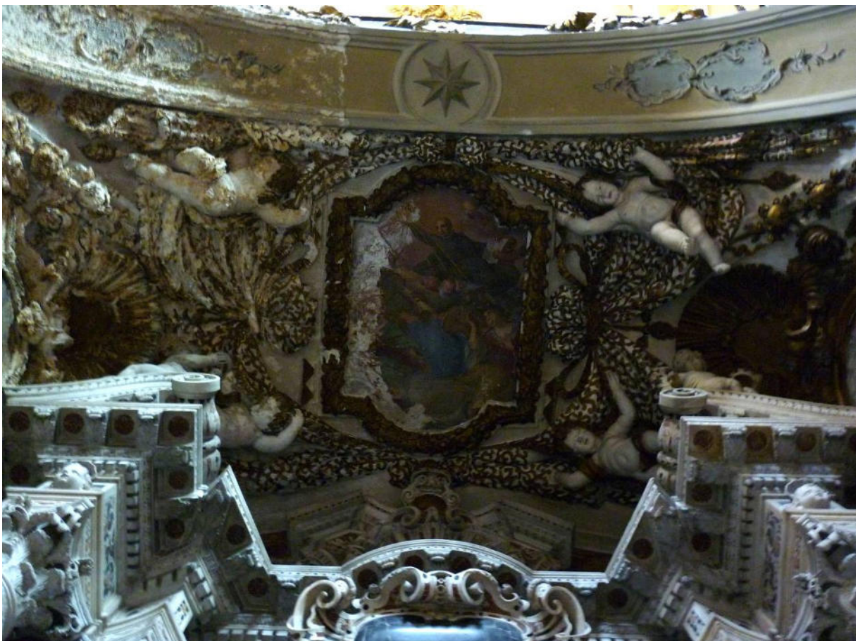
Cappella del Crocifisso, opera di Paolo Amato. La decorazione a stucco e il quadrono a fresco della volta. Si può osservare la presenza di efflorescenze saline che hanno causato il sollevamento e caduta della decorazione in oro e del film pittorico.
