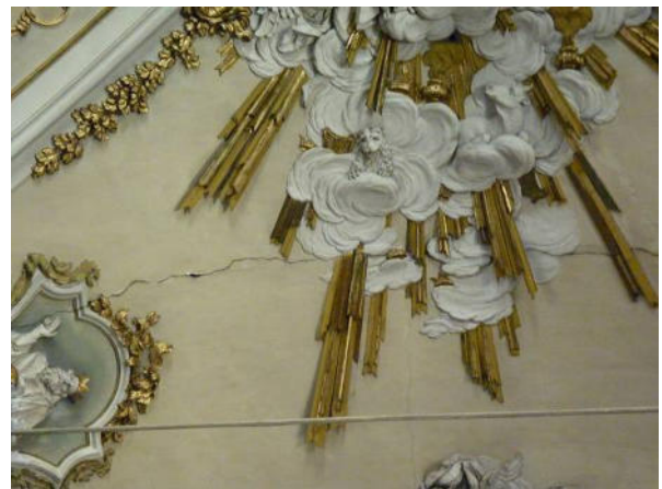
Particolare della volta della navate interessata dalle lesioni in corrispondenza delle catene
