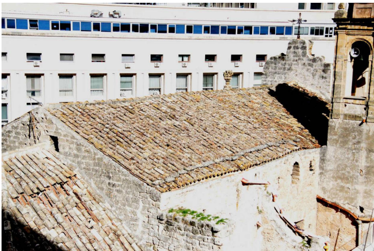
Vista del tetto della navata centrale.
