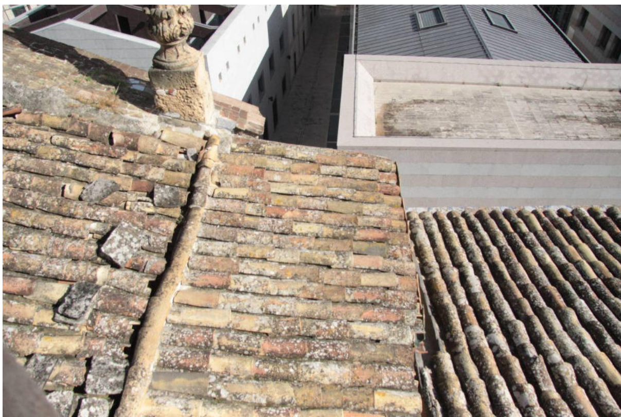
Vista del tetto della cappella del lato su-est verso il prospetto.
