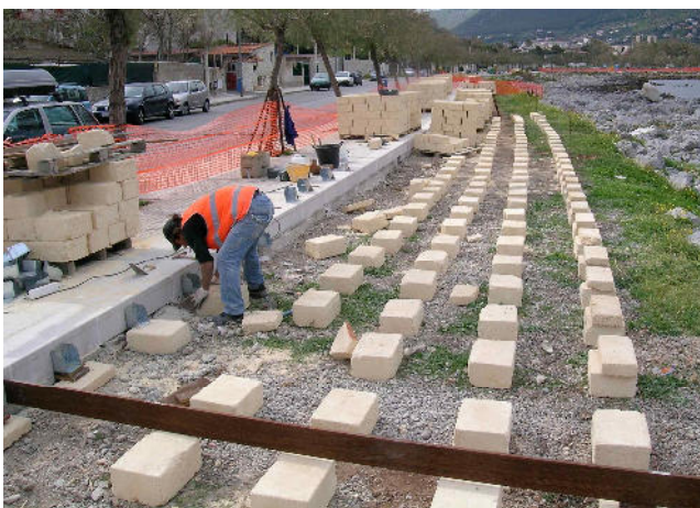
Fasi di cantiere – Il sistema portante in conci di tufo e la struttura in tubi metallici nella estremità Sud-Ovest.
