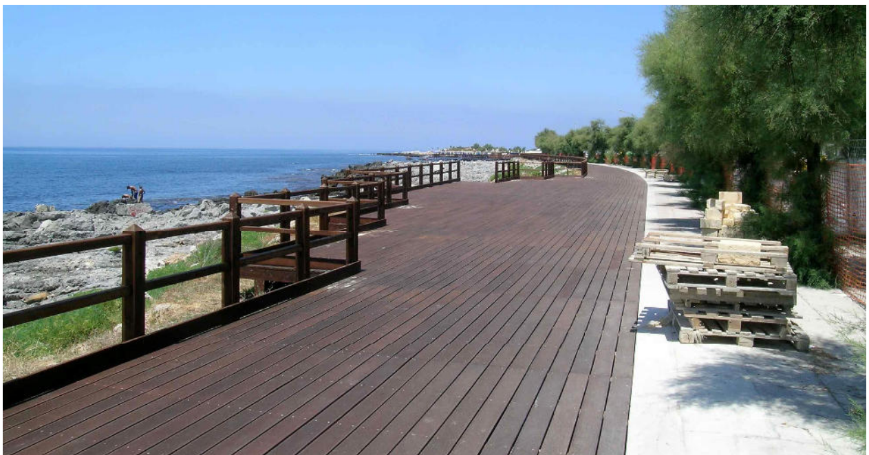
La passeggiata lignea appena realizzata
