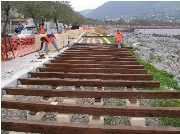
Fasi di cantiere – Le travi di sostegno ed il tavolato
