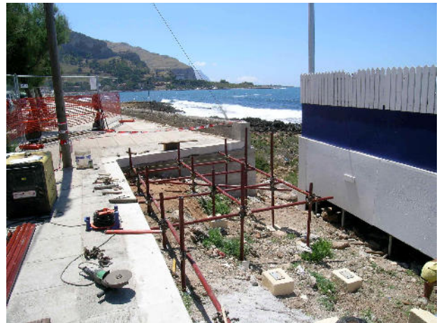
Fasi di cantiere – Il sistema portante in conci di tufo e la struttura in tubi metallici nella estremità Sud-Ovest.
