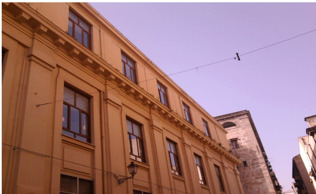
Foto 1: Prospetto su Via Valverde
