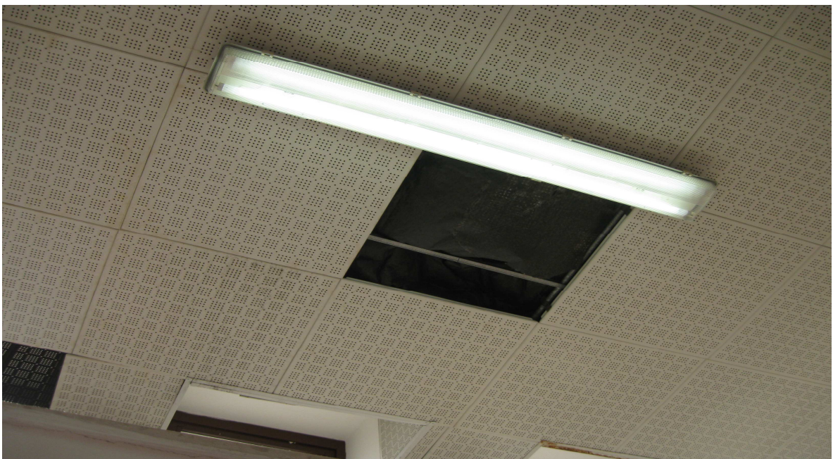
Foto 3: Controsoffitto a pannelli metallici bagni
