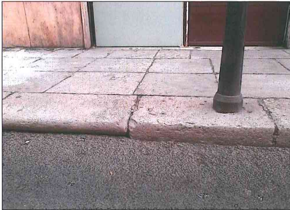
Particolare delle orlature miste dei marciapiedi su Corso Vittorio Emanuele
