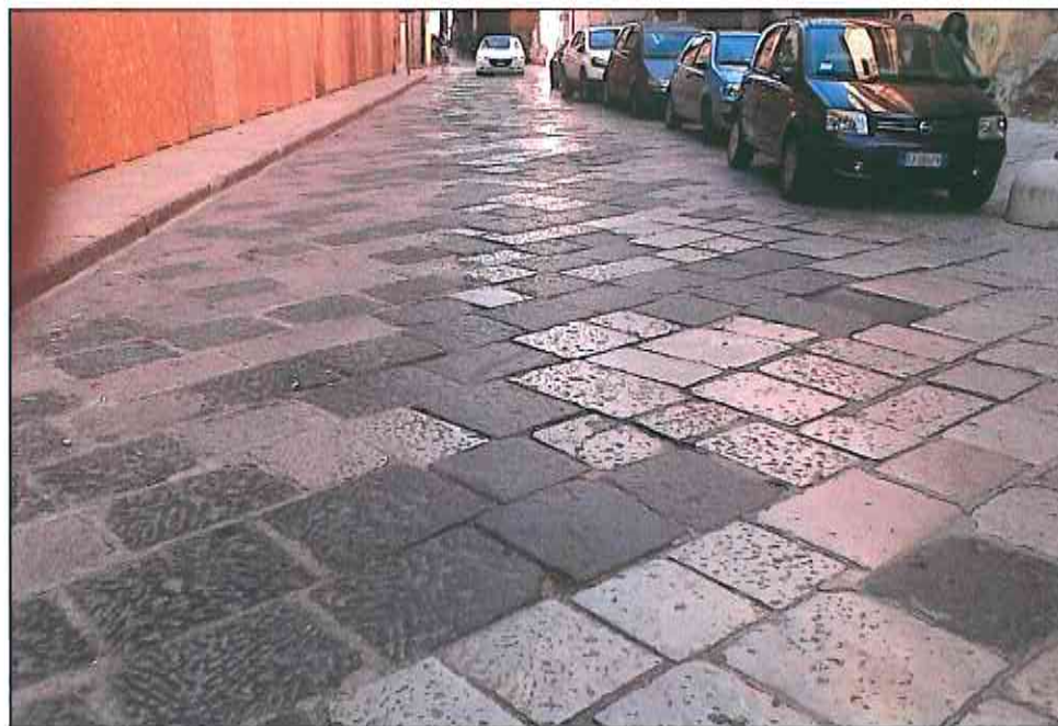
Via Valverde – Strada con basole di Billiemi alternate con pietra lavica
