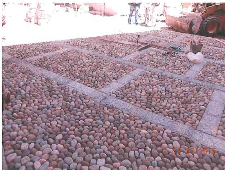
Piazza Tarzanà – Collocazione di acciottolato con riquadri in pietra calcarea
