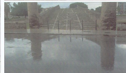
Ponte dell'Ammiraglio ingresso
