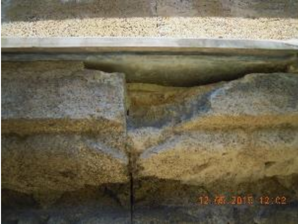
Frammento 8 - Cornice aggettante in corrispondenza della ventiseiesima mensola da sinistra del fronte 7-8
