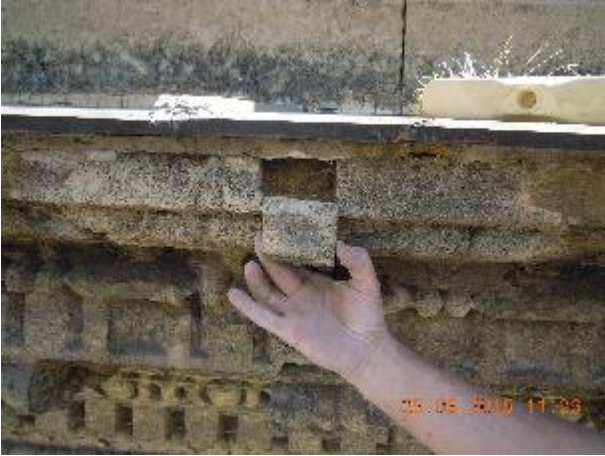
Frammento 12 - Cornice aggettante in corrispondenza della venticinquesima mensola da destra del fronte 13-14
