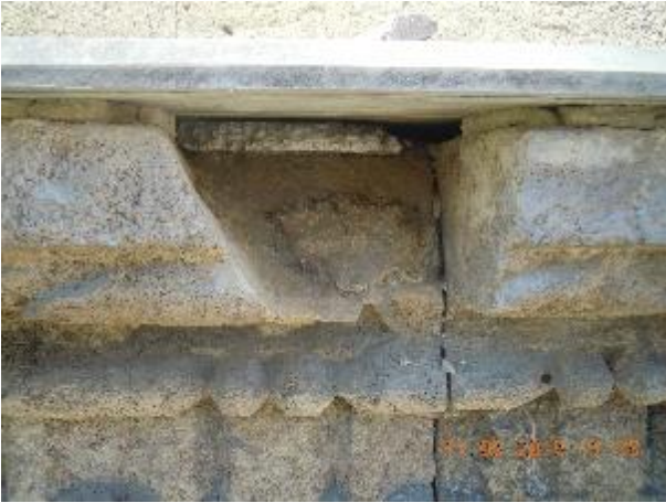
Frammento 17 - Cornice aggettante in corrispondenza della quattordicesima mensola da destra del fronte 23-24
