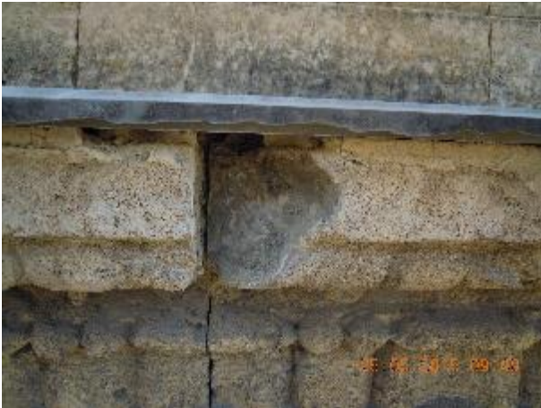
Frammento 10 - Cornice aggettante in corrispondenza dell'ottava mensola da destra del fronte 13-14
