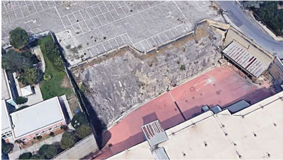
Fig. 14 - La scarpata in corrispondenza dell'area LIDL sul fronte N-NO PRIMA DELLA SISTEMAZIONE
