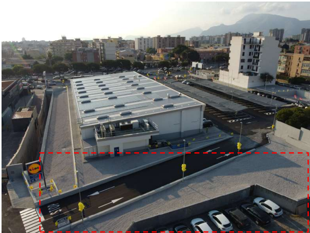
Fig. 15 - Sistemazione attuale della scarpata sull'area LIDL nel fronte N-NO
