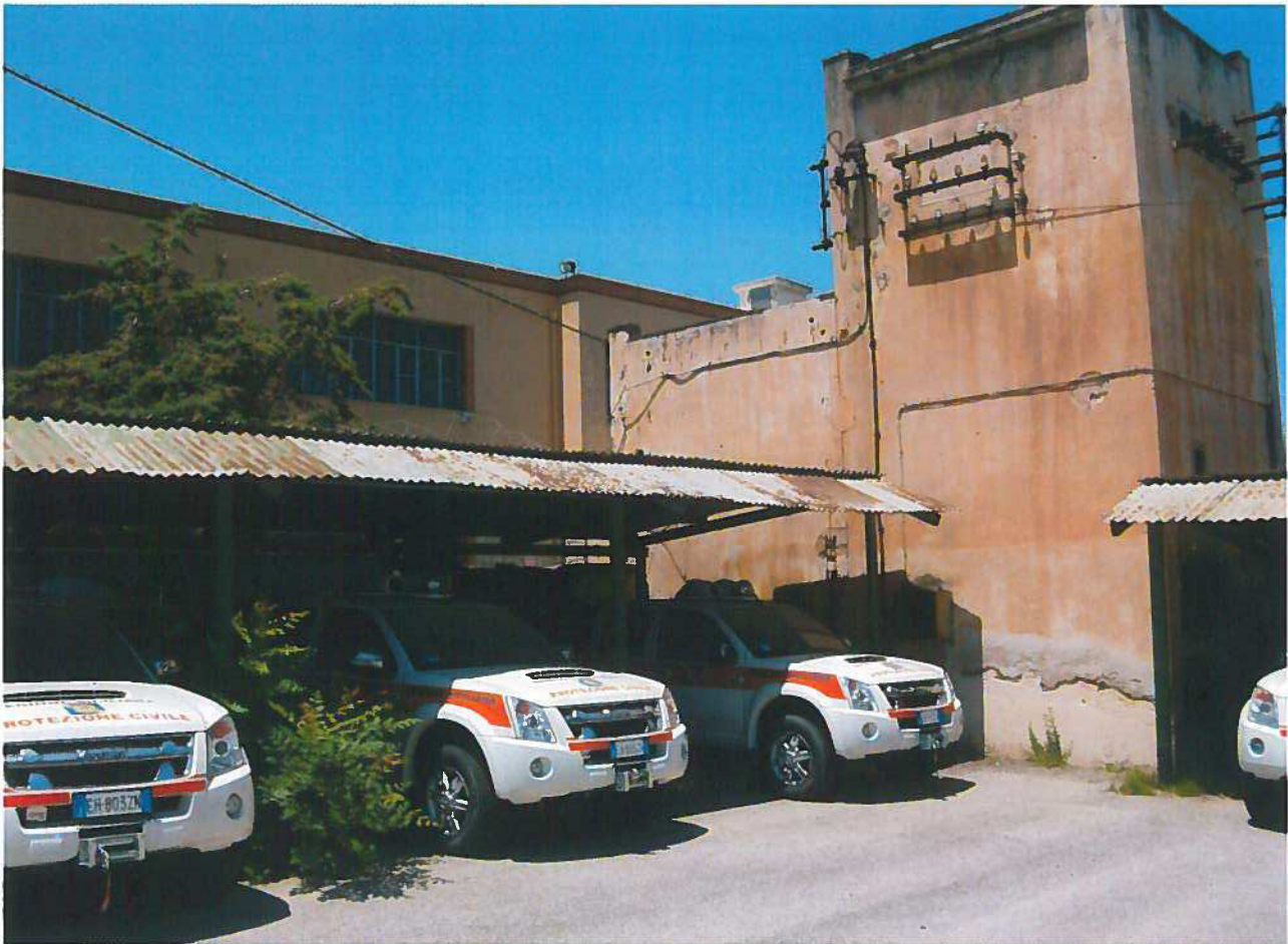
FOTO 17 – STRUTTURA DA DEMOLIRE
