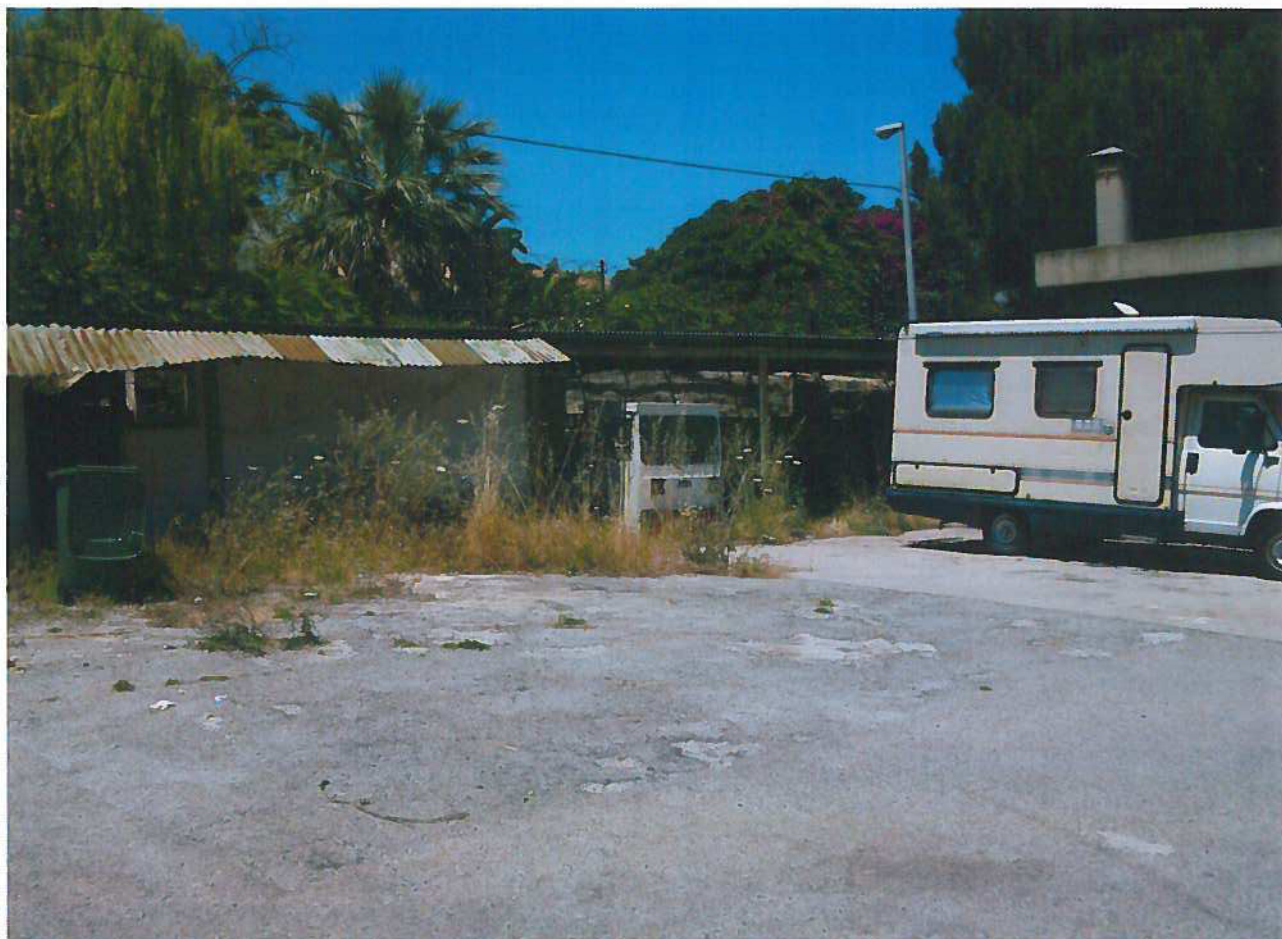
FOTO 11 – STRUTTURE DA DEMOLIRE
