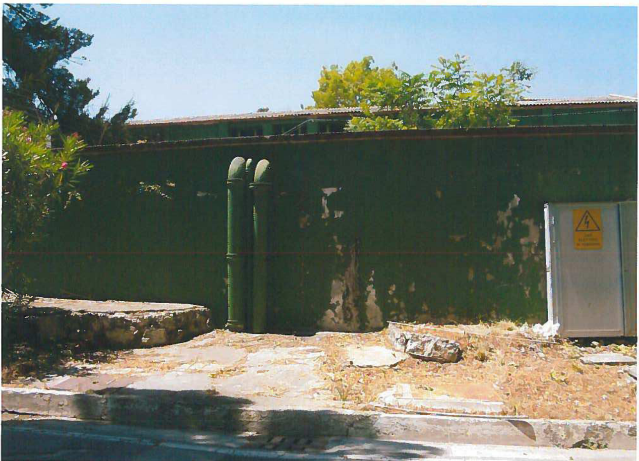
FOTO 20 – VASCA DA DEMOLIRE
