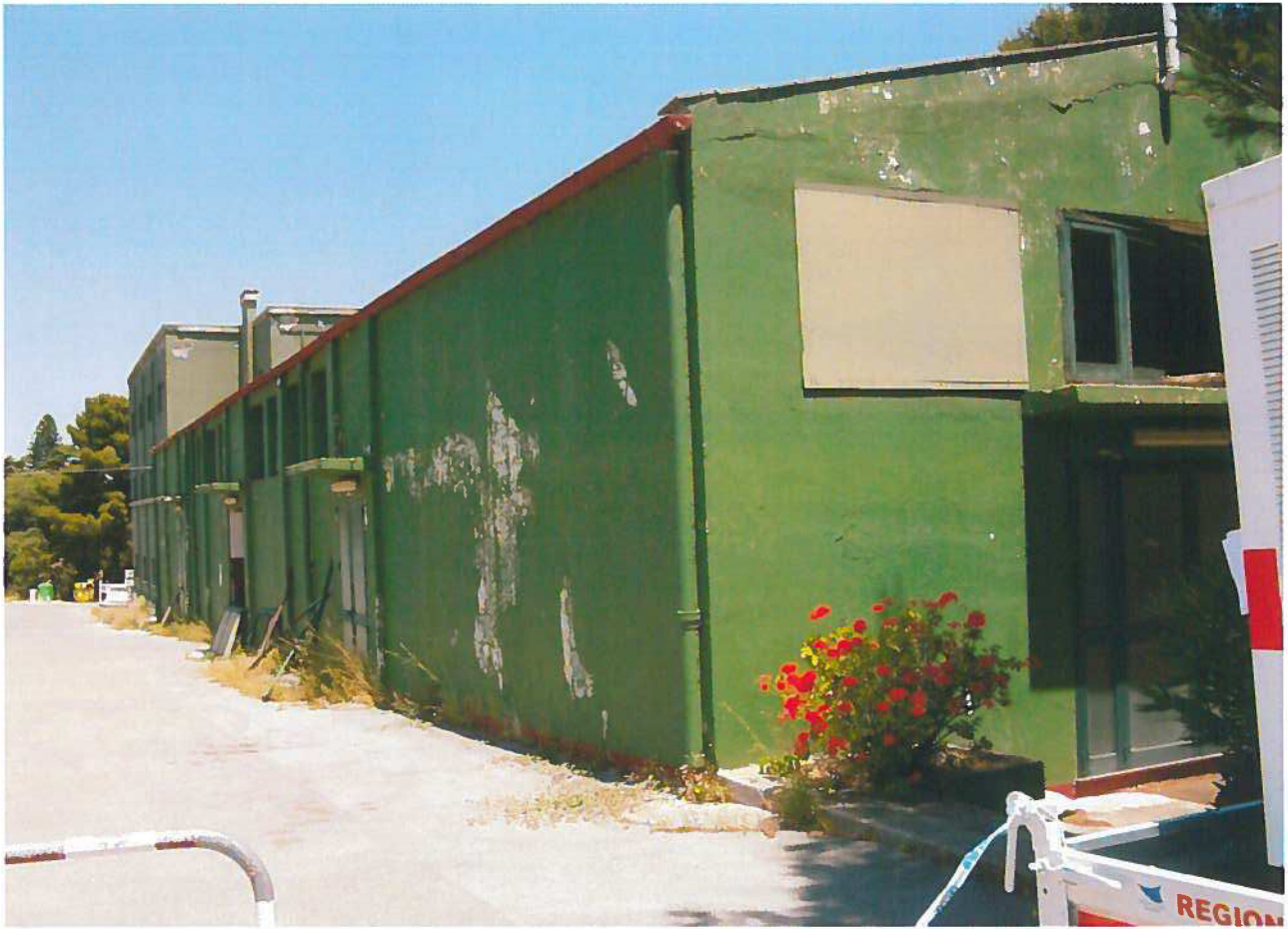
FOTO 15 – STRUTTURA DA DEMOLIRE
