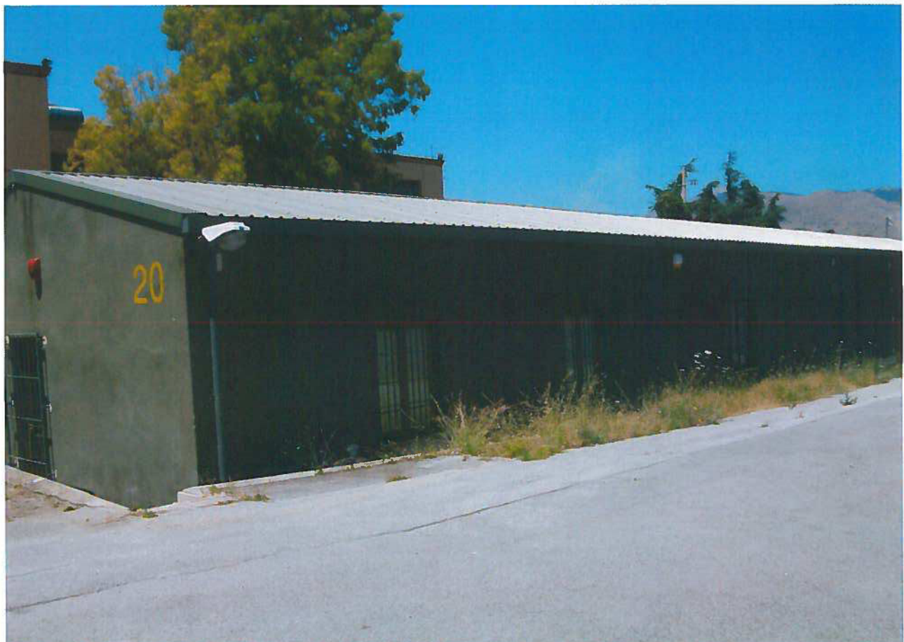
FOTO 16 – STRUTTURA DA DEMOLIRE
