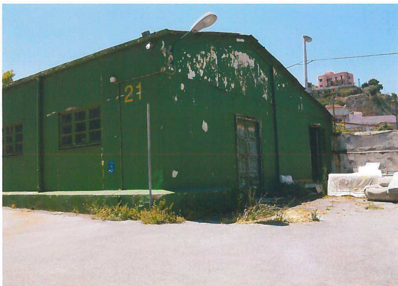
FOTO 12 – STRUTTURA DA DEMOLIRE
