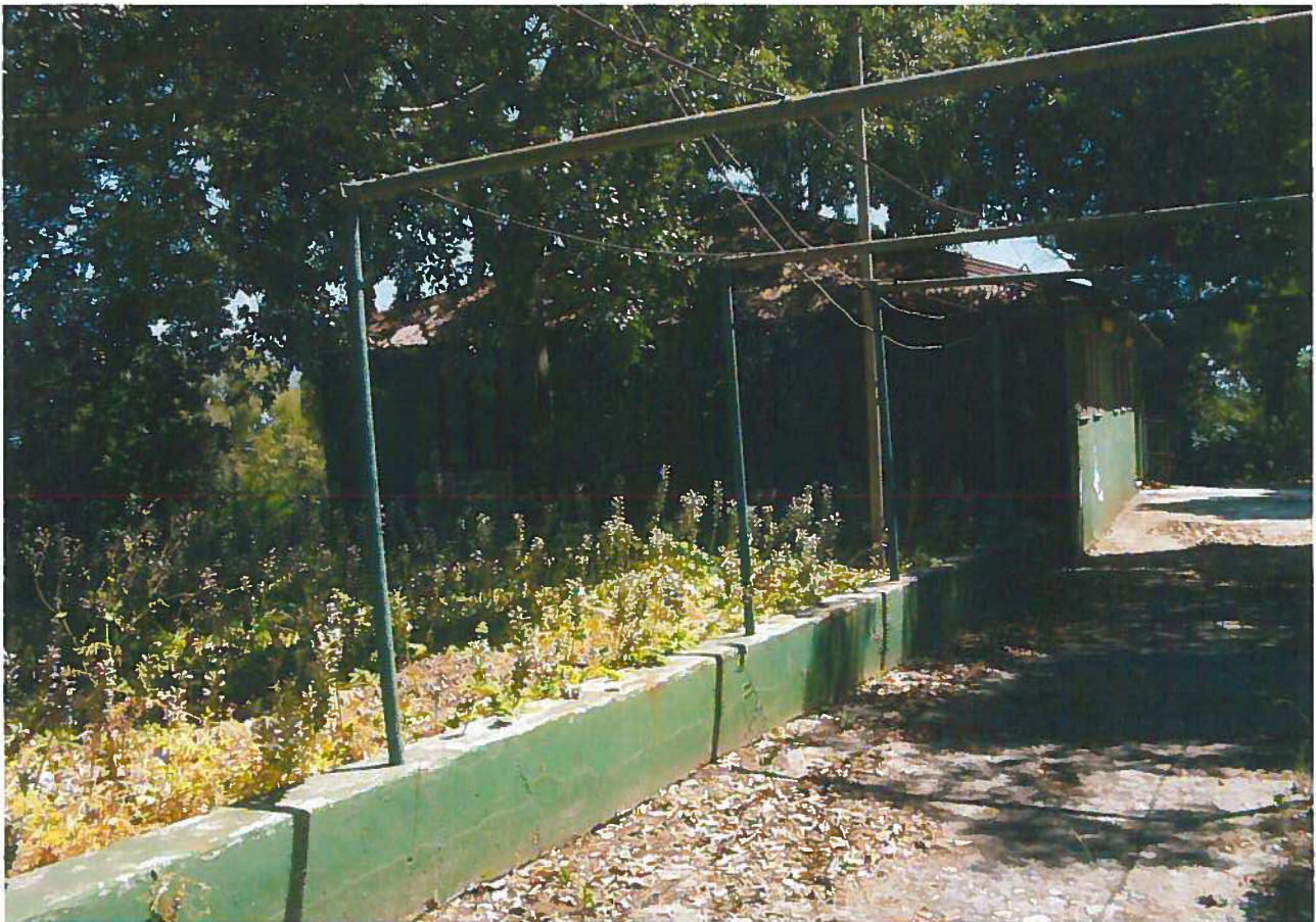
FOTO 2 – STRUTTURA DA DEMOLIRE, AREA SEDIME FUTURO EDIFICIO
