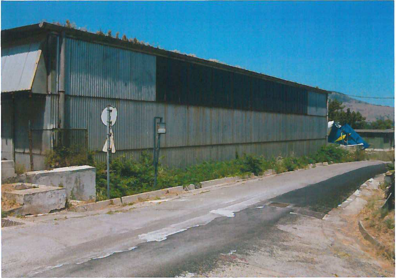
FOTO 9 – STRUTTURA DA DEMOLIRE
