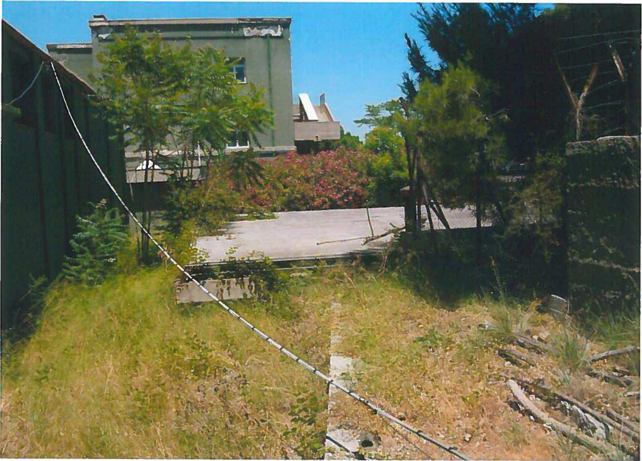
FOTO 19 – VASCA DA DEMOLIRE
