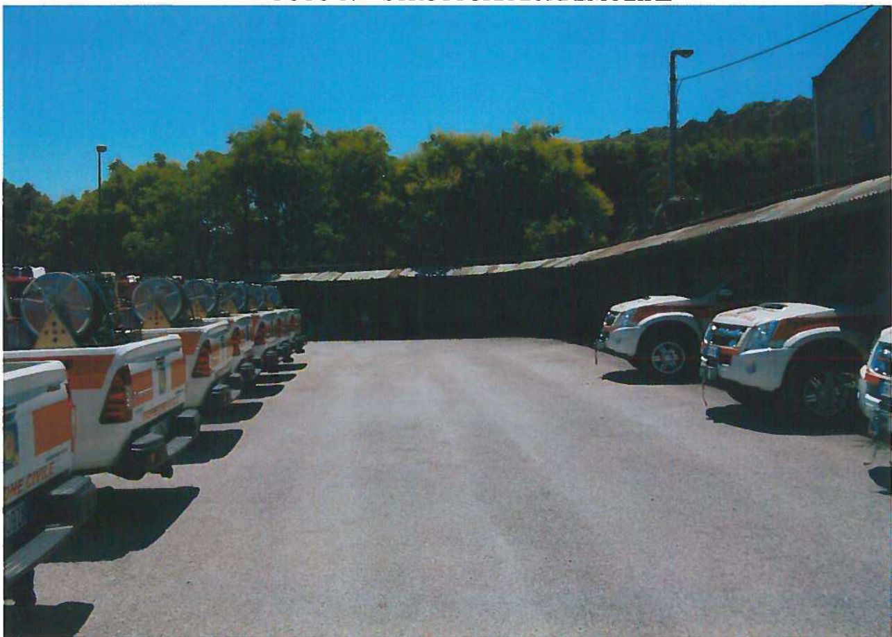
FOTO 18 – STRUTTURA DA DEMOLIRE
