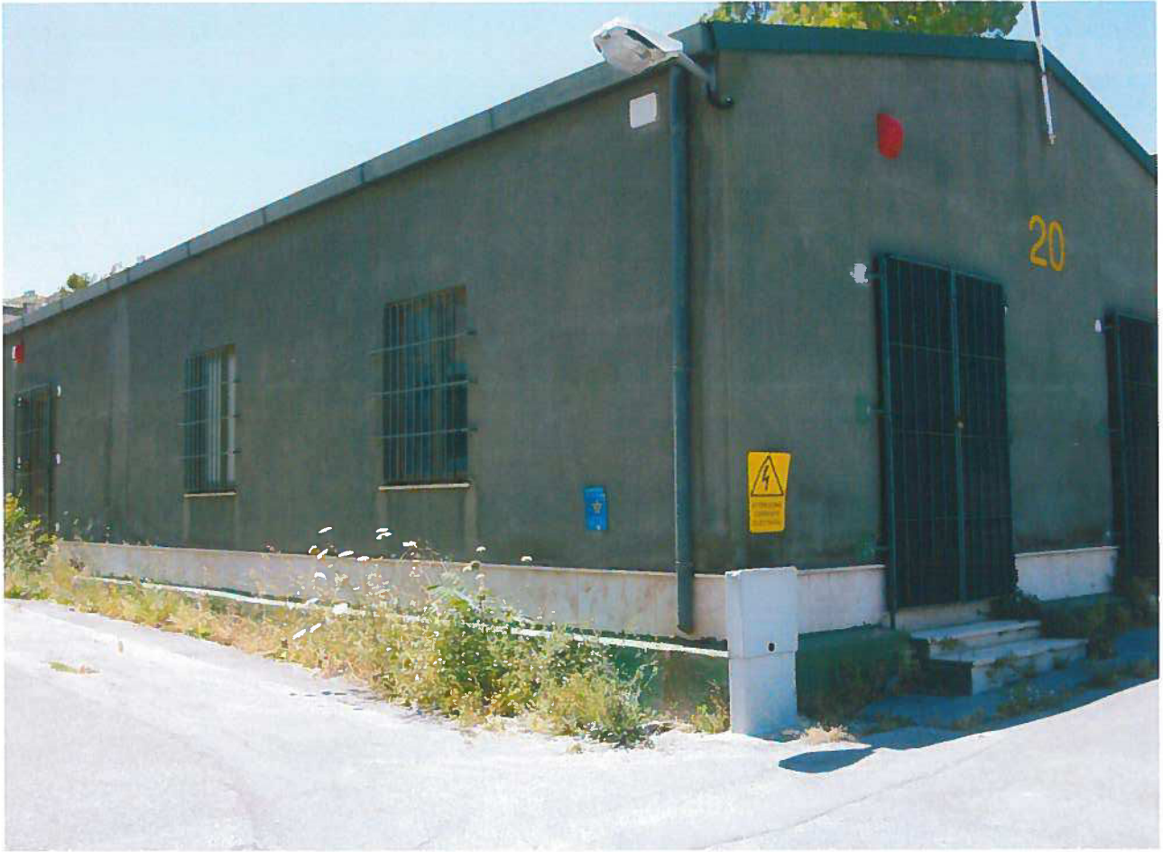
FOTO 13 – STRUTTURA DA DEMOLIRE
