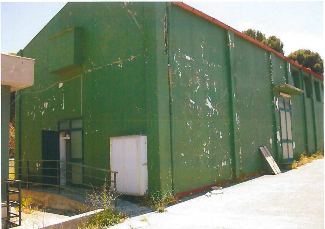
FOTO 14 – STRUTTURA DA DEMOLIRE
