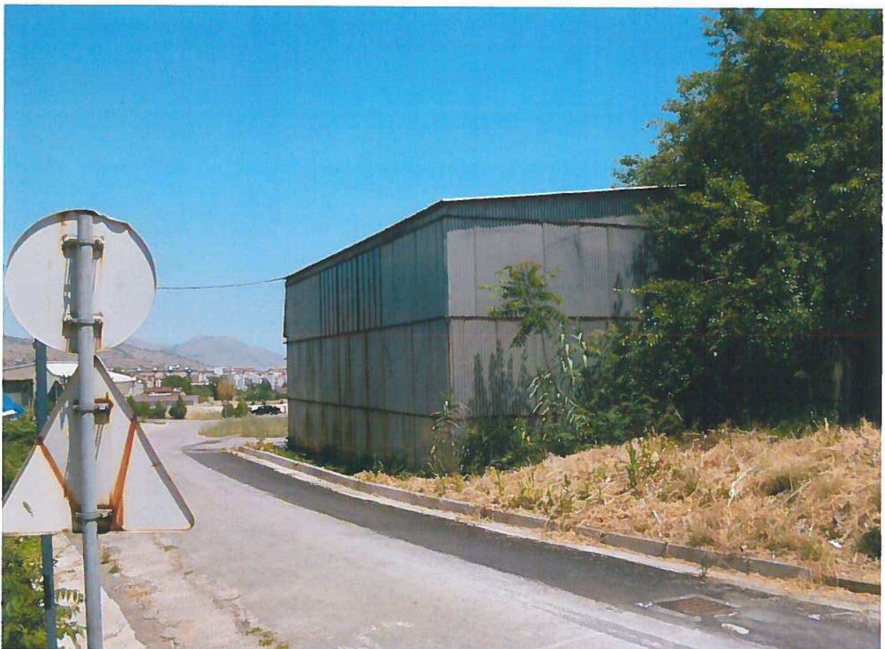
FOTO 8 – STRUTTURA DA DEMOLIRE, SEDE NUOVO HANGAR
