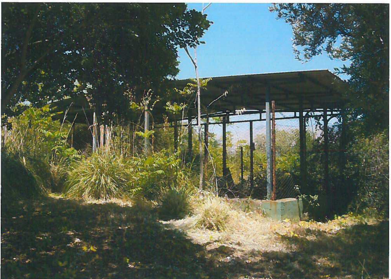
FOTO 6 – STRUTTURA DA DEMOLIRE, AREA SEDIME NUOVO EDIFICIO
