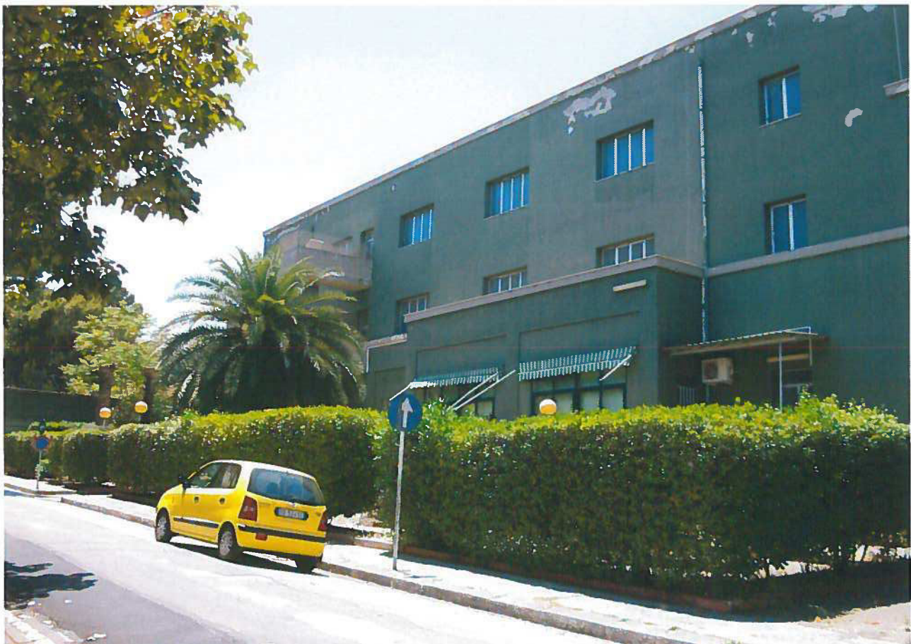
FOTO 10 – EDIFICIO DA MANUTENZIONARE PER USI SUSSIDIARI
