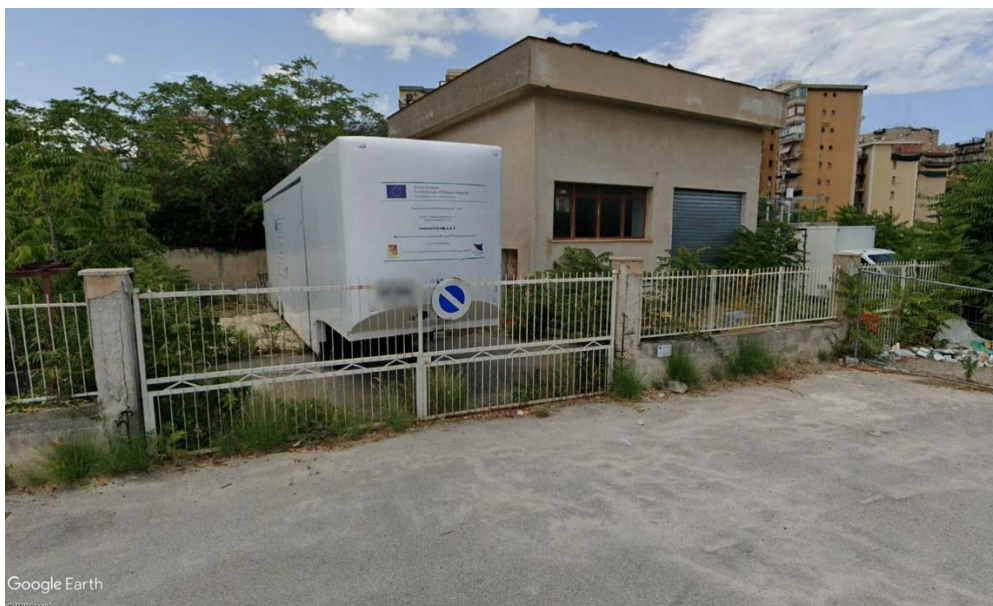
Figura 4 - Macchinari presenti nell'area di intervento
