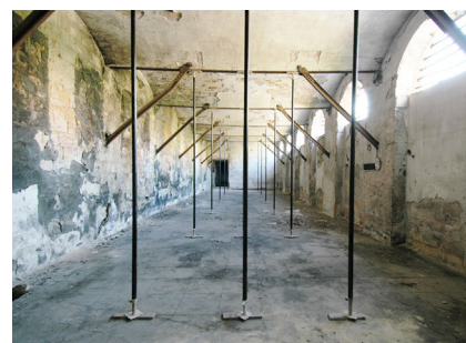
Interno della Sala con volte e puntoni
