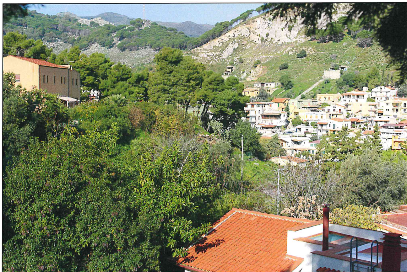
VISTA PANORAMICA SITUAZIONE ATTUALE
