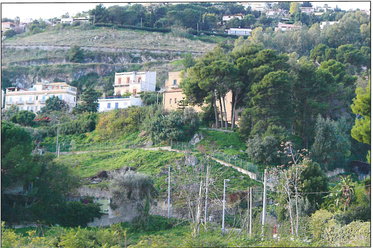
VISTA PANORAMICA SITUAZIONE ATTUALE
