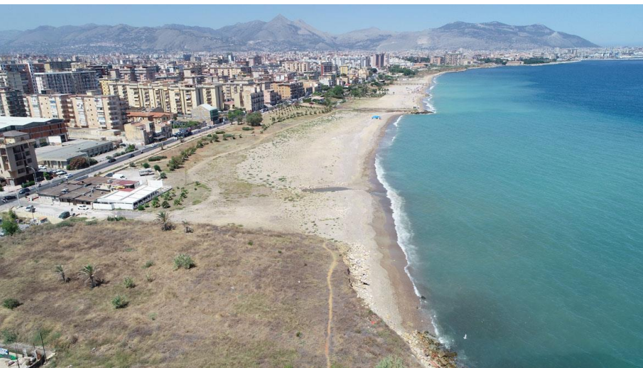
Il tratto di costa sistemato a Romagnolo
