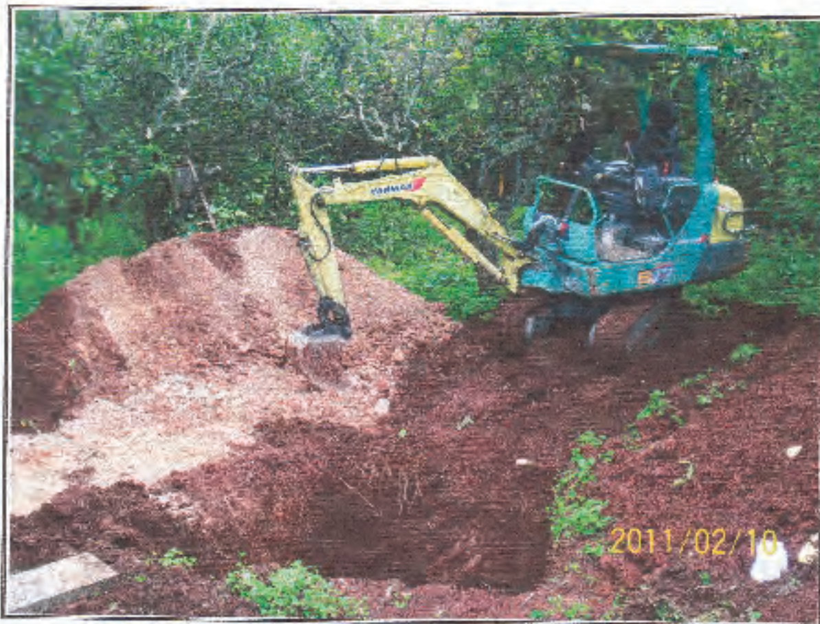
Pozzetto geognostico S.1 (postazione su foro)
