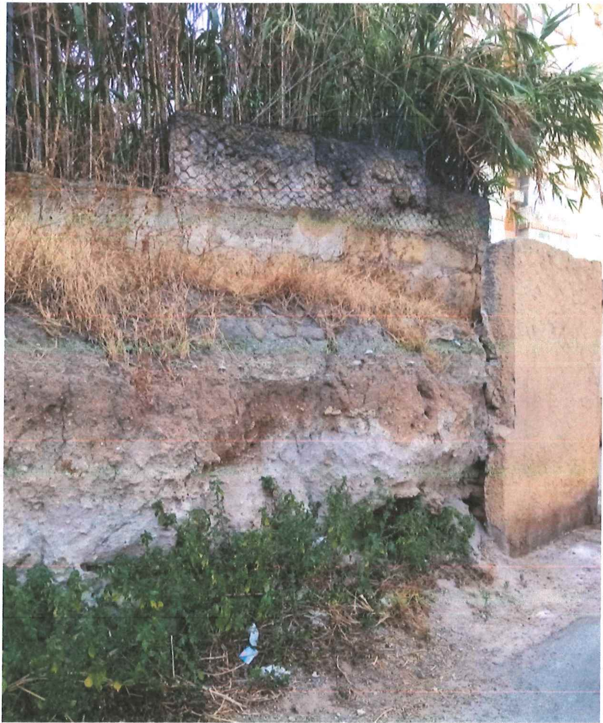
FOTO 3: Lato Nord-Ovest (particolare)
