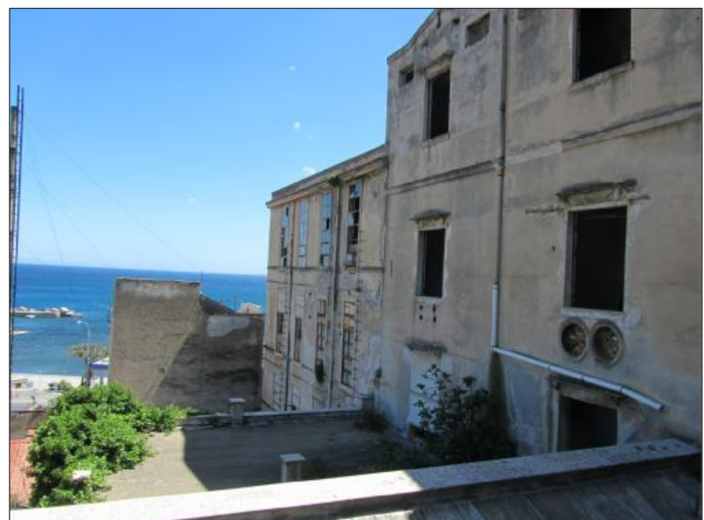
FOTO 16: VISTA VERSO IL MOLINO (EDIFICI 1 e 6)
