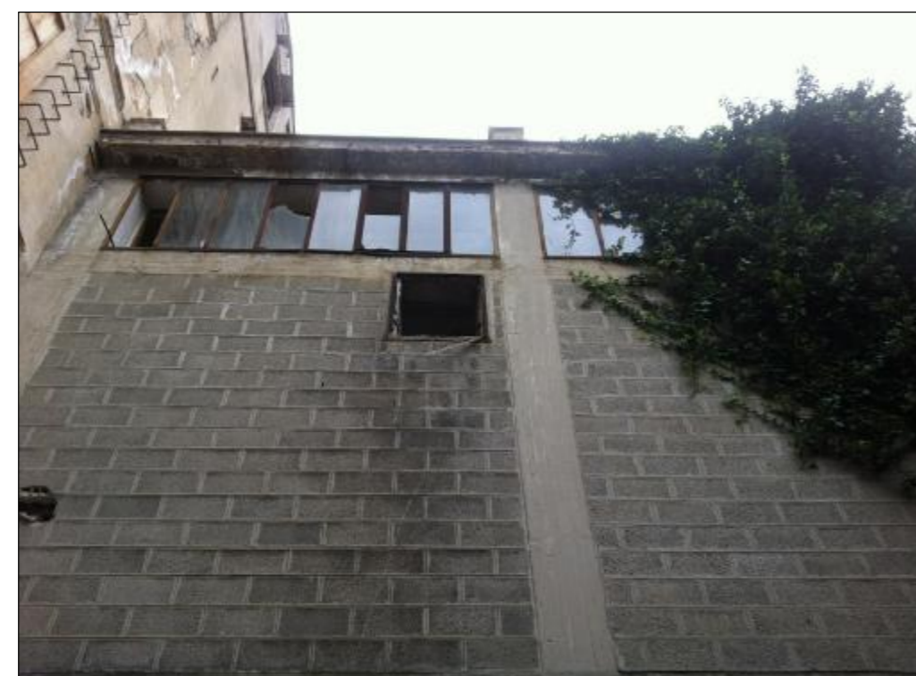
FOTO 18: VISTA SULL'EDIFICIO 5bis
