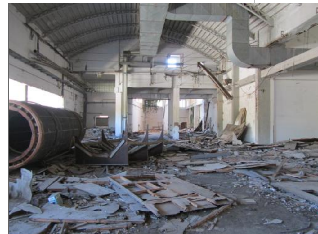
FOTO 5: LOCALI DI LAVORAZIONE (2)
