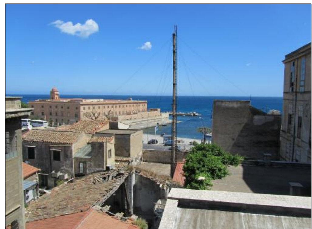
FOTO 12: VISTA DAL MOLINO (1) VERSO L'EDIFICIO 4bis E VERSO L'INGRESSO SU PIAZZA TONNARAZZA
