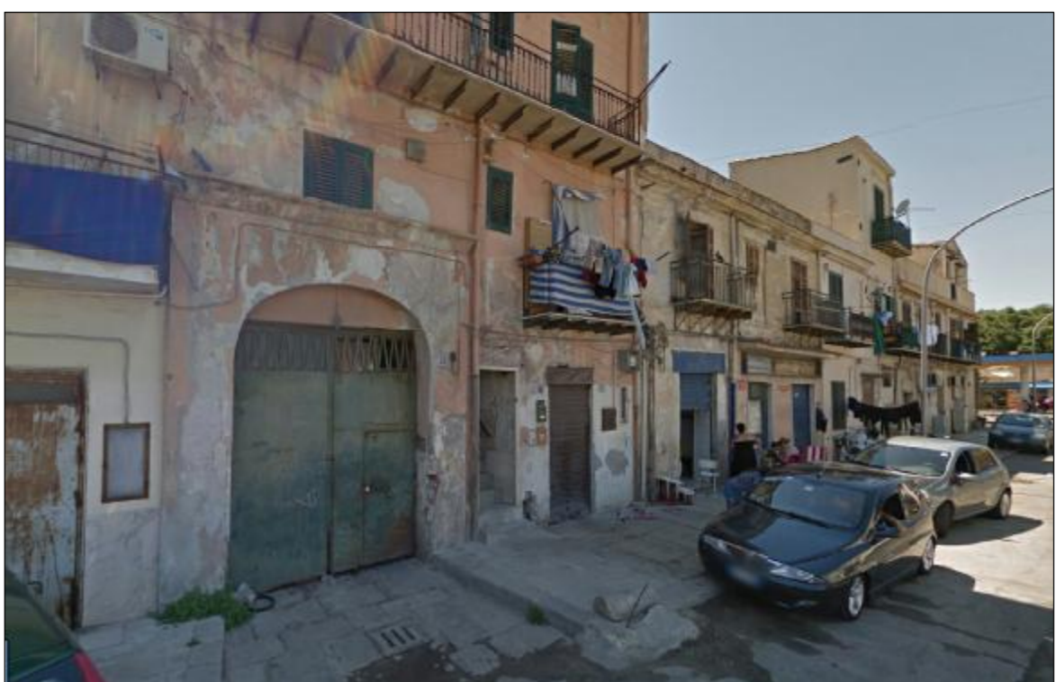
FOTO 24: INGRESSO SU PIAZZA TONNARAZZA
