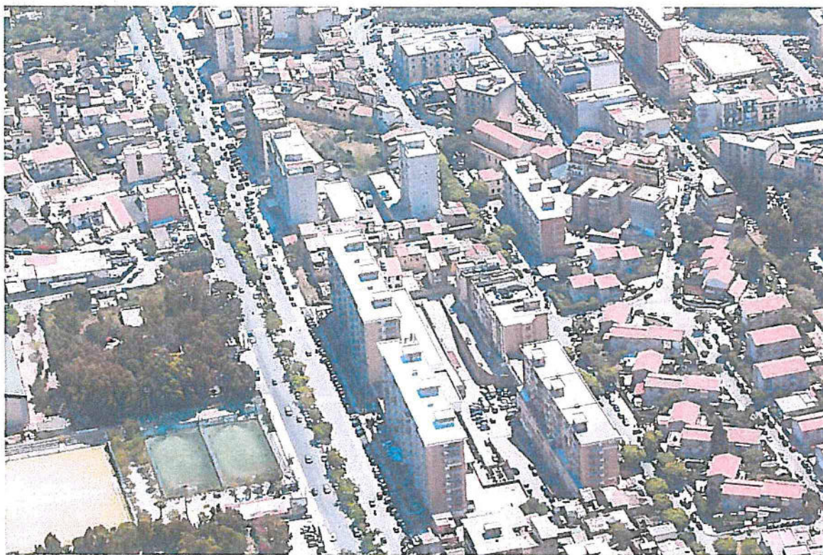
Foto 8 – Vista di parte delle aree residenziali in Zona di Tutela B e C – Testata 17 Nord
