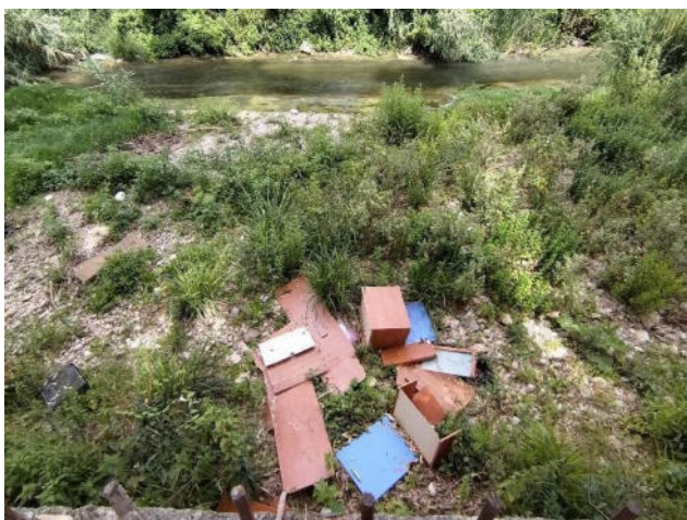
Presenza di rifiuti ingombranti lungo gli argini.
