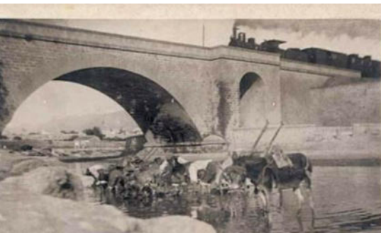
Il ponte ferroviario 1900
